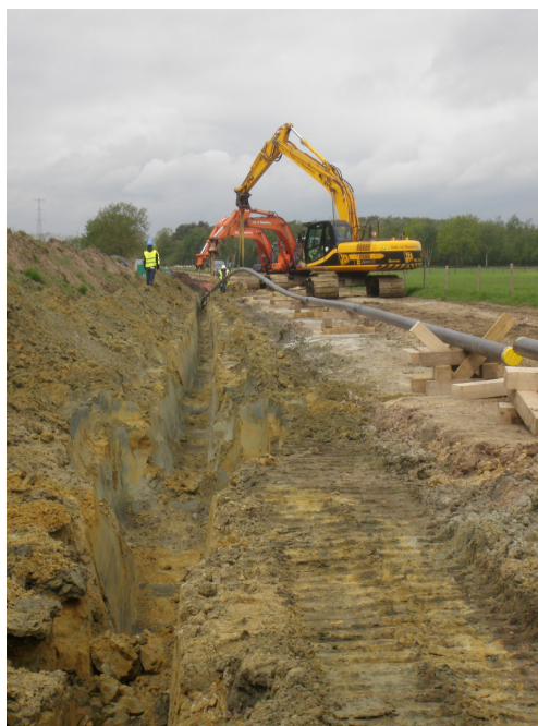
Afbeelding 7: Sfeerfoto genomen bij aanleg van de pijpleiding in de uitgegraven C-sleuf.
