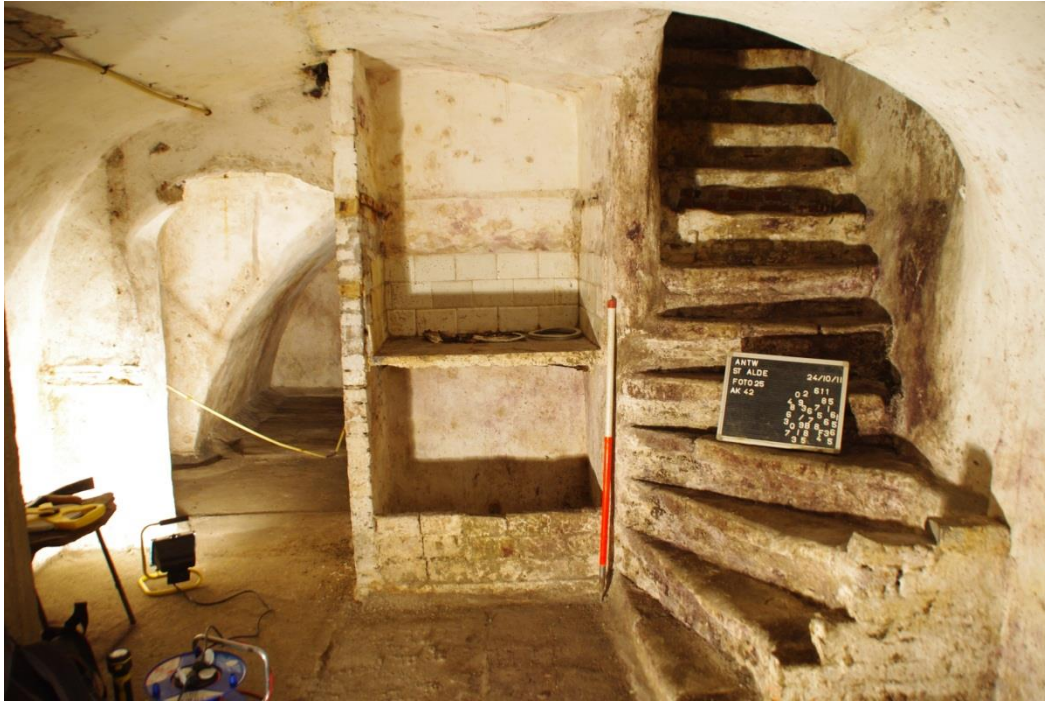
Afbeelding 23. Zuidwand van ruimte 1 van de kelder van Sint-Aldegondiskaai 42 (ruimte 6).
