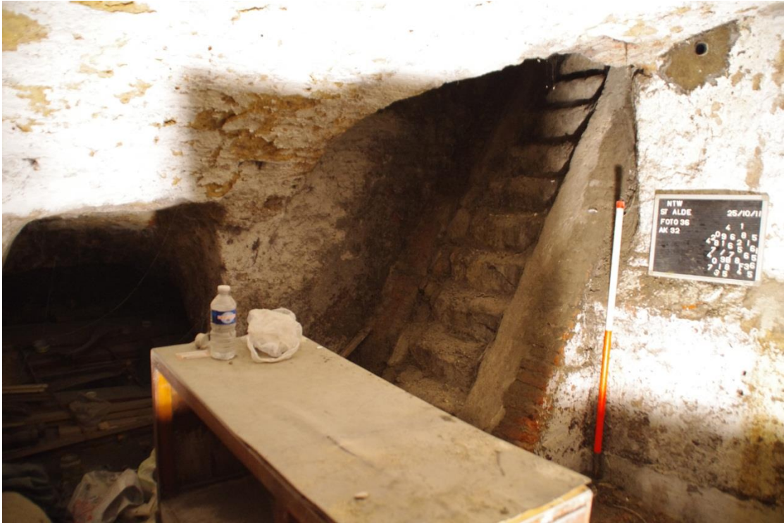
Afbeelding 29. Zicht op de noordwestelijke hoek.
