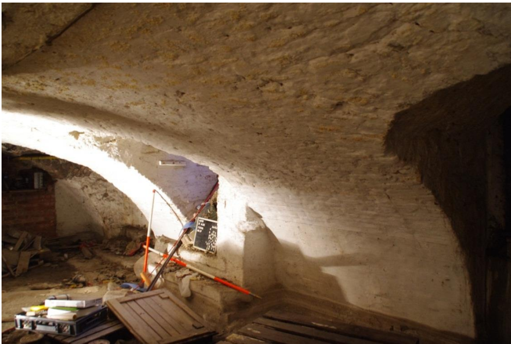
Afbeelding 19. Zuidwand van ruimte 1 van de kelder van het pand aan de Adriaan Brouwerstraat 27.
