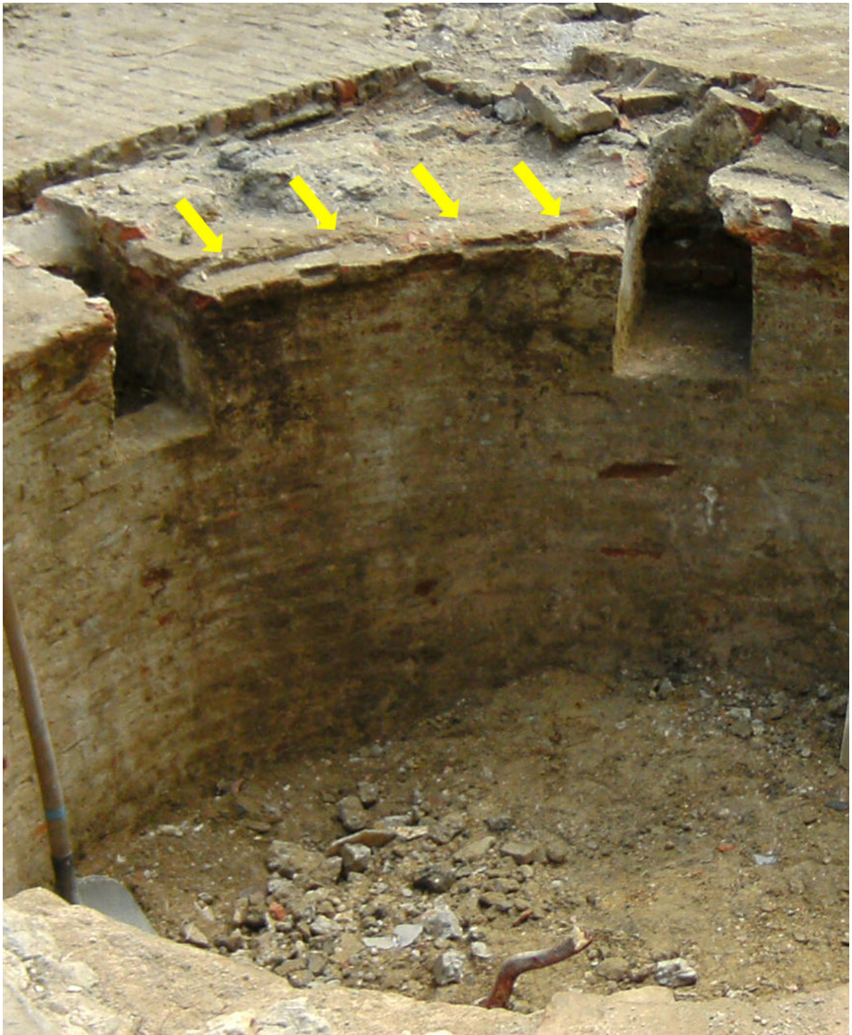
Figuur 21. Aanzet van het gewelf van de ijskelder (gele pijlen). (Foto Triharch)
