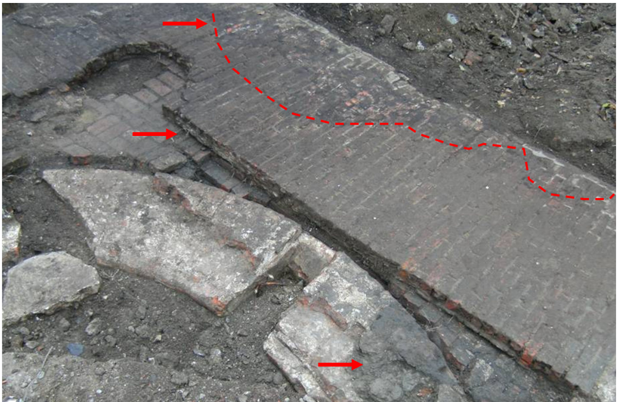
Figuur 30. Voorbeelden van vorst- en waterschade aan de archeologische resten van de site. (Foto triharch)
