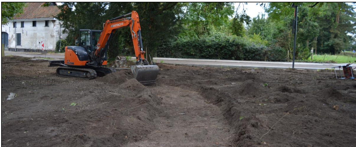
Afb. 18-20: Zicht op de werken: SL1 tijdens de opgraving/prospectie, begeleiding van de rioleringsleuf, begeleiding van de aanleg van het wandelpad.
