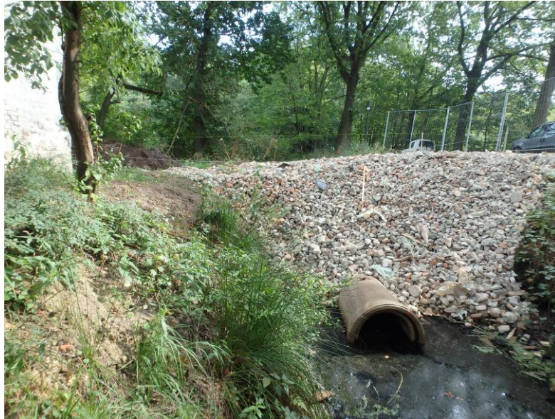
Figuur 8 : Zicht op de brug die wordt aangelegd.
