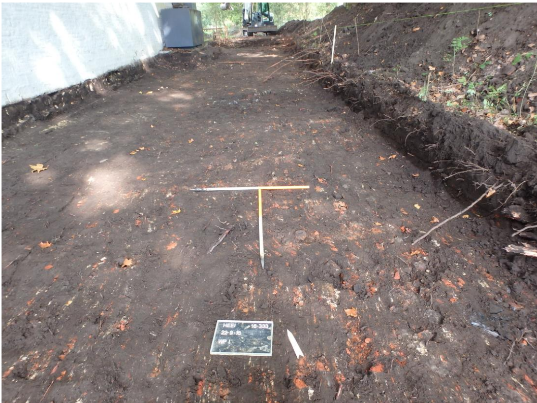
Figuur 11: Overzichtsfoto werkput 1 (Archebo bvba, 2016)
