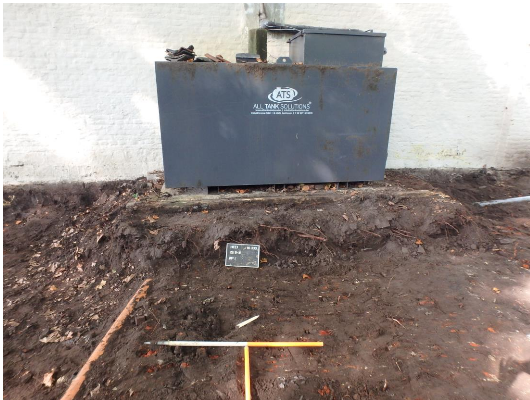
Figuur 14: Overzicht van buizen en tank (Archebo bvba, 2016)
