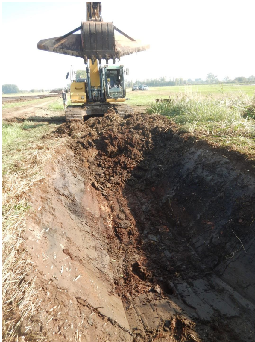
Fig. 25: fotografische opname van de aanleg van de gracht net ten oosten van de Pollaertstraat
