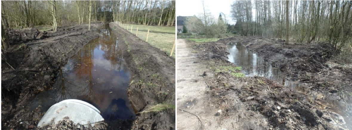
Figuur 7: De reeds aangelegde bedding (ARCHEBO bvba, 2017).
