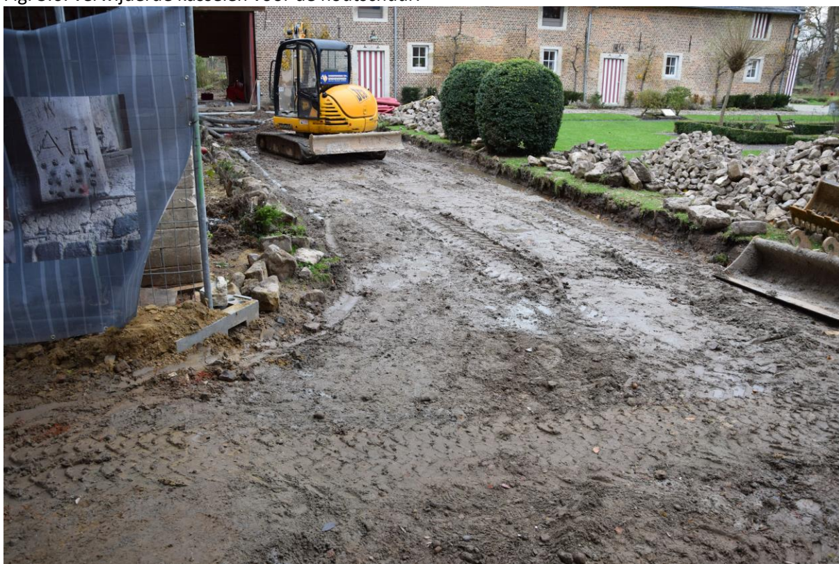
Fig. 3.7: Verwijderde kasseien tussen de houtschuur en de hoekschuur.
