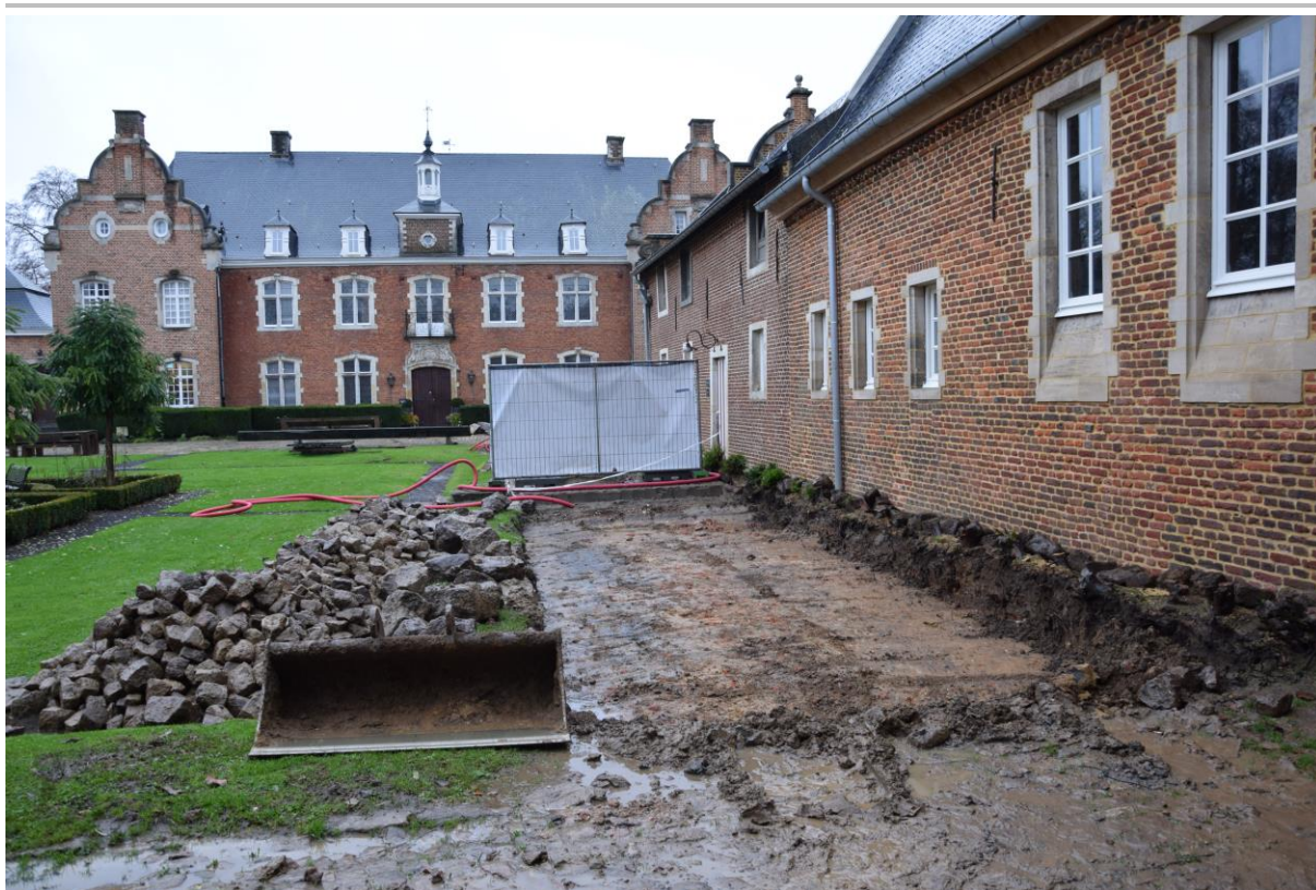
Fig. 3.8: Verwijderde kasseien tussen de houtschuur en de hoekschuur.
