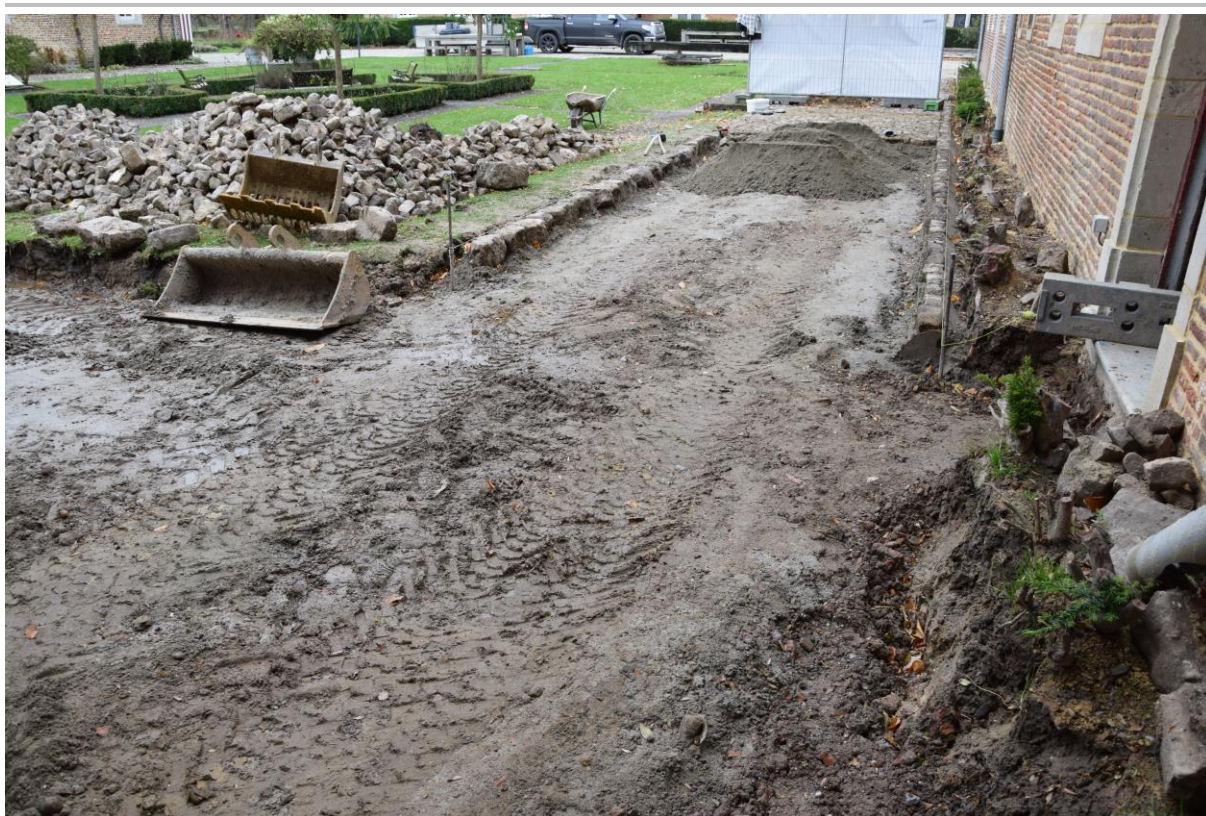
Fig. 3.6: verwijderde kasseien voor de houtschuur.
