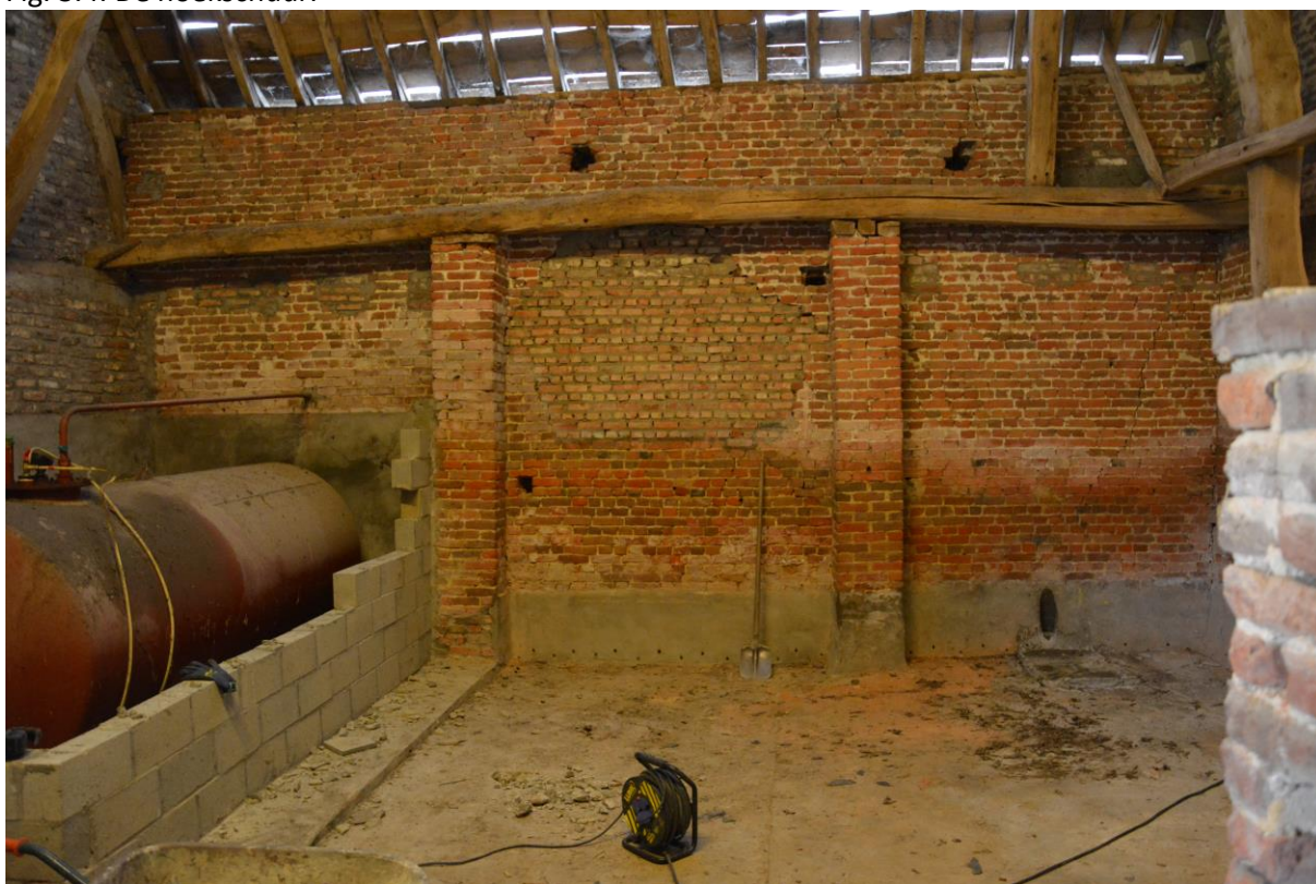
Fig. 3.5: Betonplaat en stookolietank in de hoekschuur.
