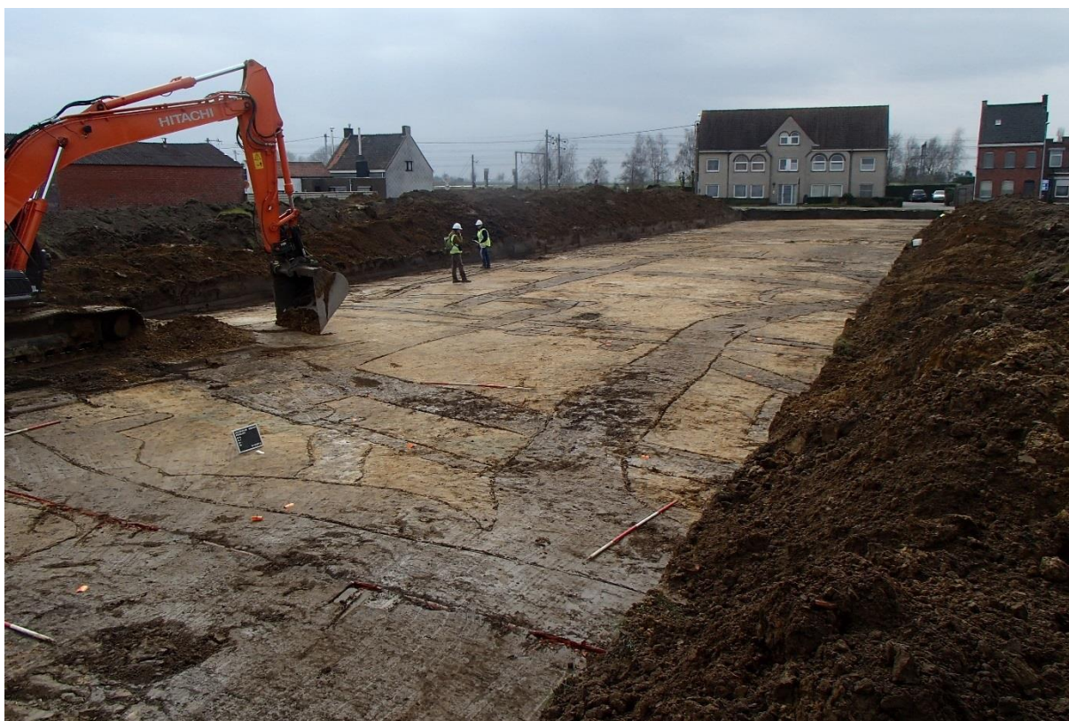
Figuur 17: Aanleg van werkput 3
