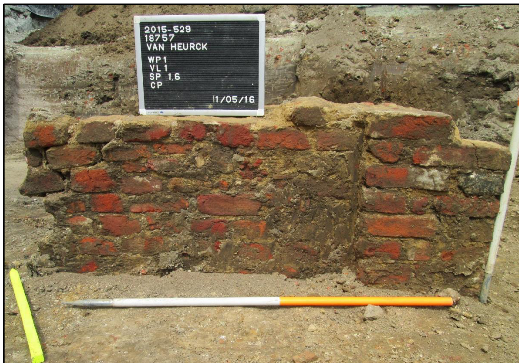
Figuur 29: Bakstenen muur spoor 1.6 met dagkant en slag
