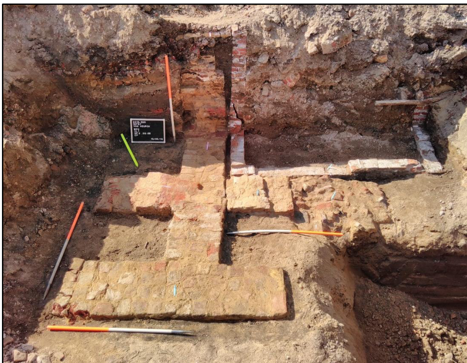
Figuur 62: Algemeen zicht op het eerste archeologische niveau van WP 2 vanuit het noordoosten
