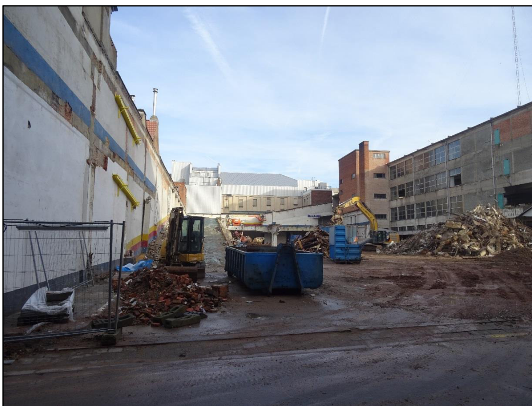
Figuur 11: Toestand van het terrein tijdens de sloop van bestaande gebouwen (2016)
