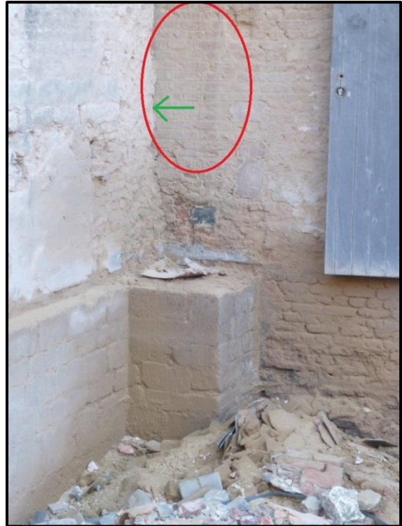
Figuur 34: Ingesneden voeg bij bouwnaad 3.
