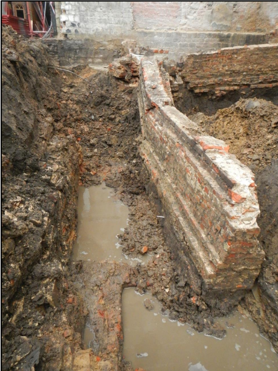
Figuur 78: Zicht op de ingestorte muur (M16) en het ondergelopen vlak.
