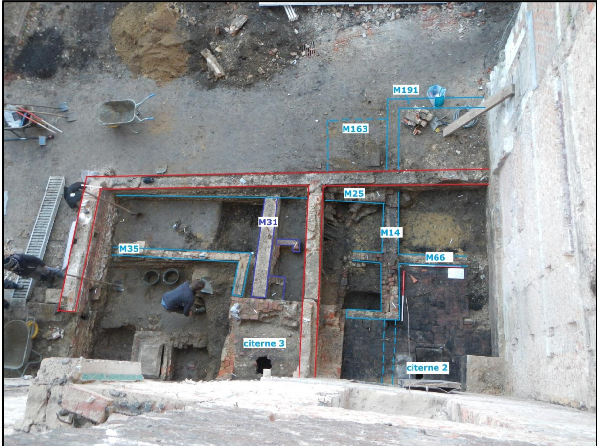
Figuur 89: overzicht van gebouw B, de muren zijn in het blauw aangeduid, gezien vanuit het zuiden
