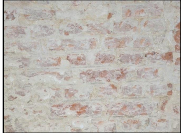
Figuur 40: Idem, detail ingesneden voegen.
