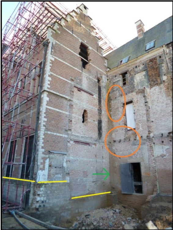
Figuur 33: Zicht op bouwnaad 3 en dichtgemetselde ramen.
