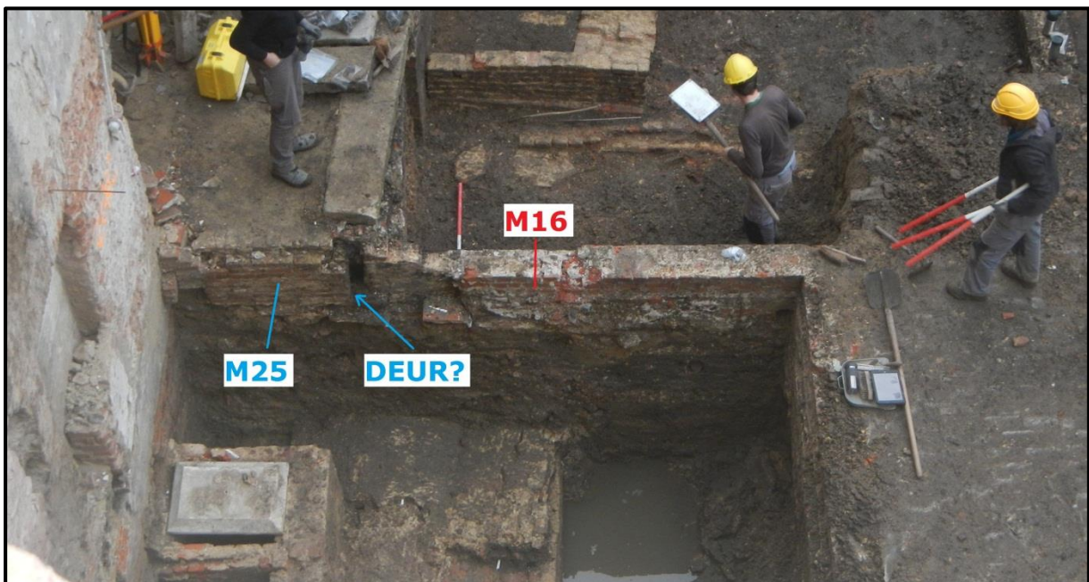
Figuur 91: Achtergevel van gebouw B, detail gezien vanuit het oosten
