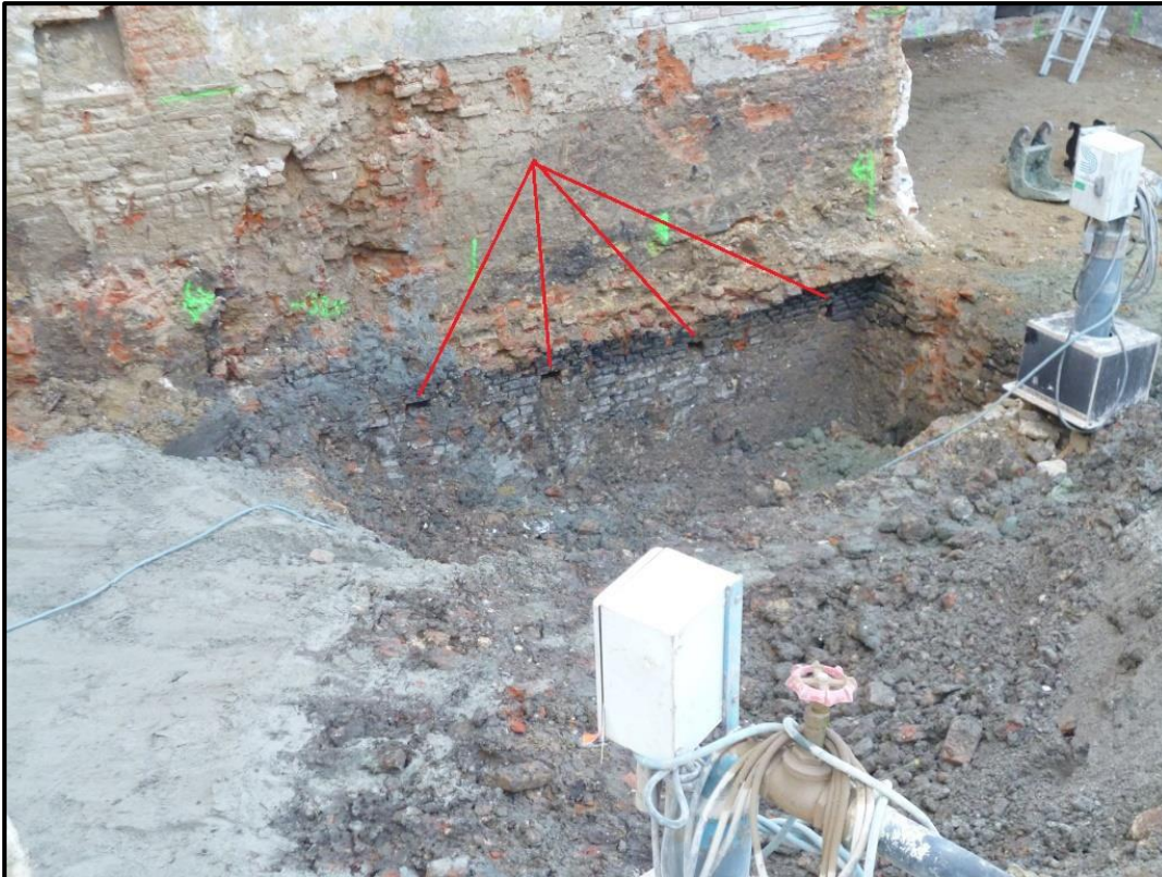
Figuur 71: Zicht op een deel van Beerput 3 na de afbraak, de rode lijnen wijzen op gaten die gebruikt werden om het formeel te bouwen. Op het gewelf zelf is duidelijk de zwarte aanslag van een beervulling te zien.
