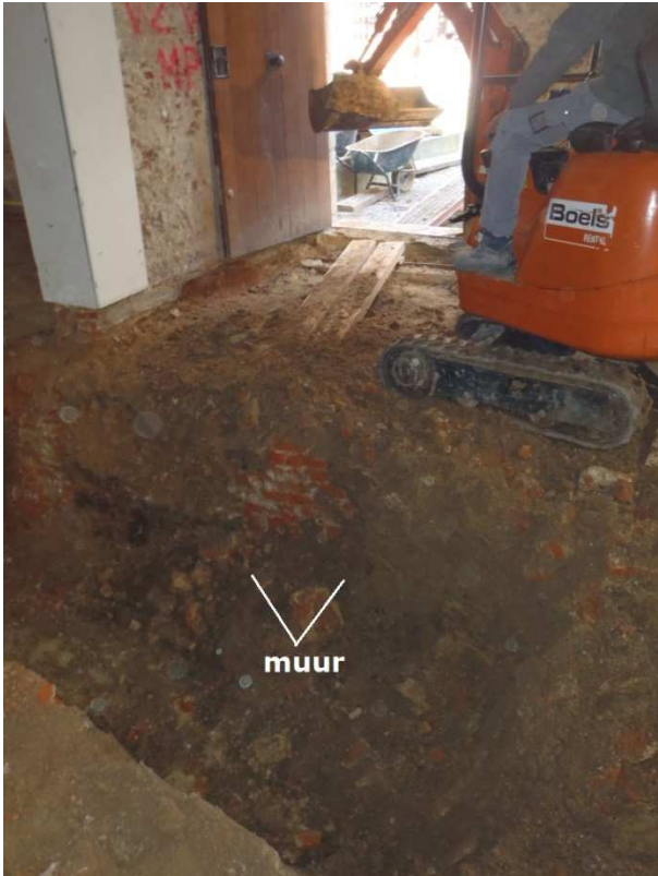
Muur en vloerlaag onder de voormalige 'Classe'.
