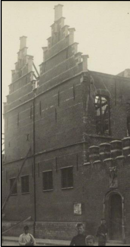
Figuur 28: blinde voorgevel in de F. de Merodestraat
