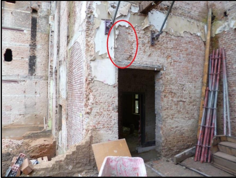
Figuur 37: 'Salle à Manger', kant van de 'Corridor', ingesneden voegen.
