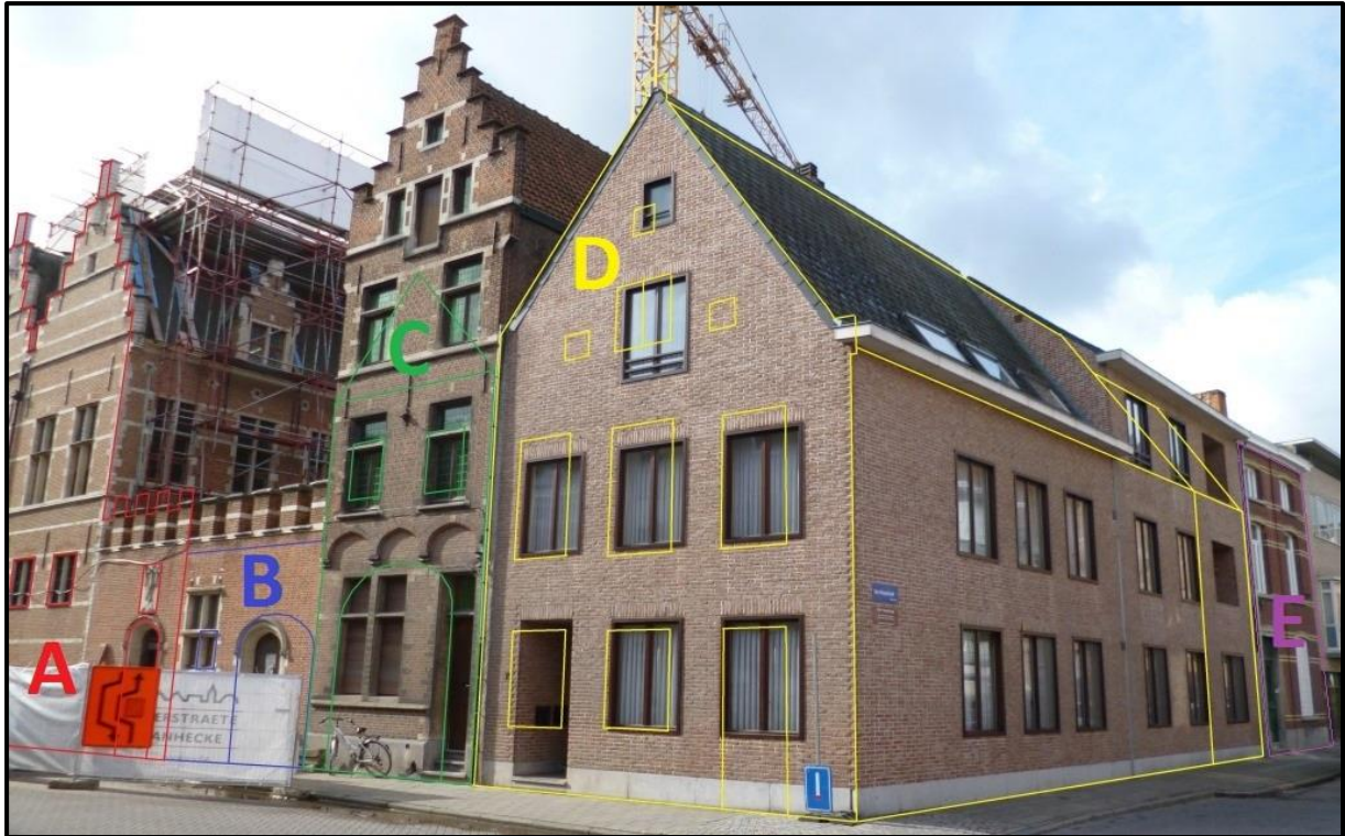
Figuur 6: Zicht op de huidige gevels
