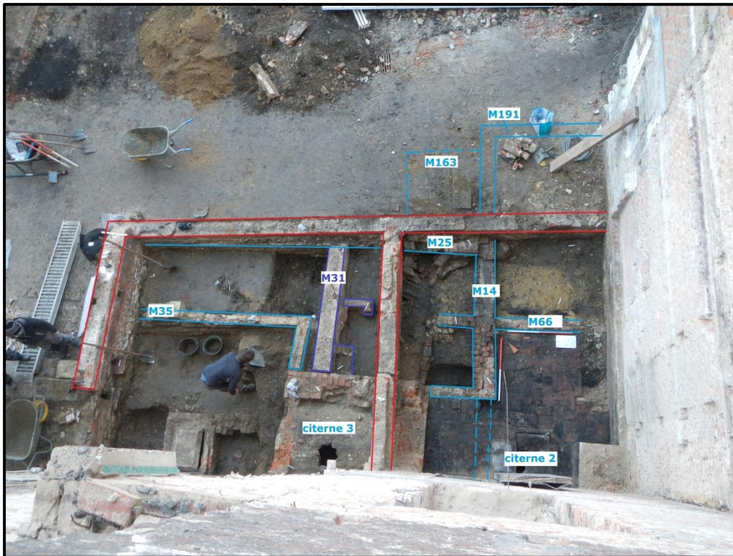
Figuur 108: Overzicht gebouw B in realiteit (muren in het blauw aangeduid)
