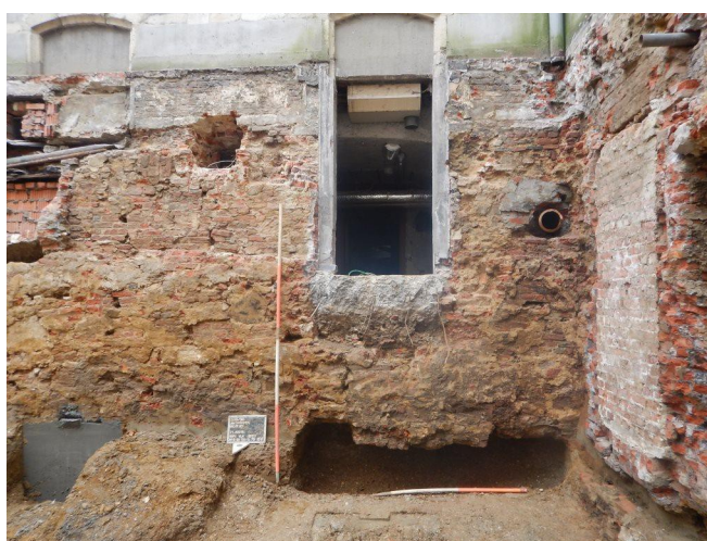
Fig. 52: Westzijde fundering gebouwvleugel ten zuiden van binnenkoer
