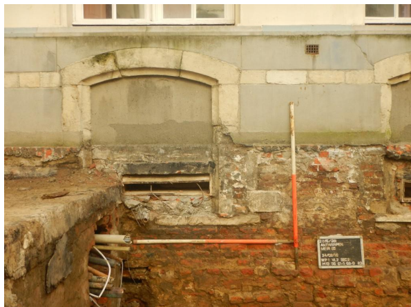
Fig. 53: Verbouwingen aan raam in muur van gebouwvleugel ten zuiden van binnenkoer
