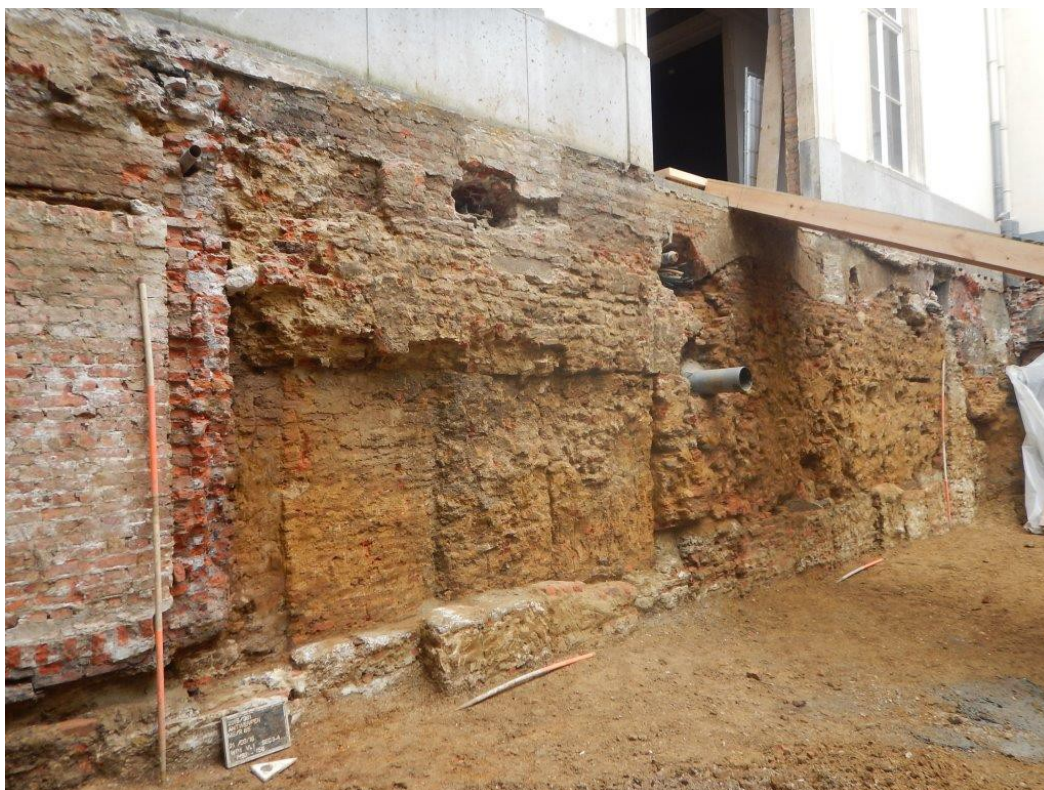
Fig. 56: Overzicht fundering van gevel aan westzijde binnenkoer
