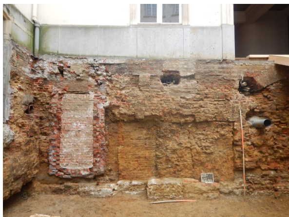
Fig. 58: Zuidelijk bouwvolume ter hoogte van de westzijde van de binnenkoer met vermoedelijk 17de- of 18de-eeuwse onderschoeiing. Onderaan de onderschoeiing uit 1954
