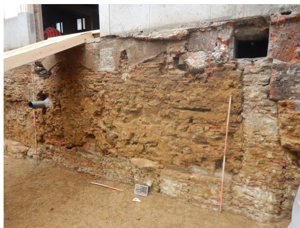
Fig. 59: Noordzijde van de fundering aan de westzijde van de binnenkoer, met het centrale onderkelderde bouwvolume en in het uiterste noorden de fundering van het initieel niet-onderkelderde noordelijke bouwvolume. Beide delen werden onderschoeid in 1954
