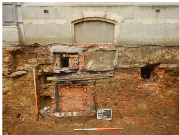
Fig. 54: Detail van muur gebouwvleugel ten zuiden van binnenkoer met verschillende muuropeningen
