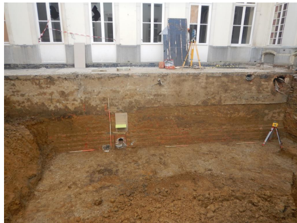
Fig. 73: Fundering kelder van oostvleugel (M6)
