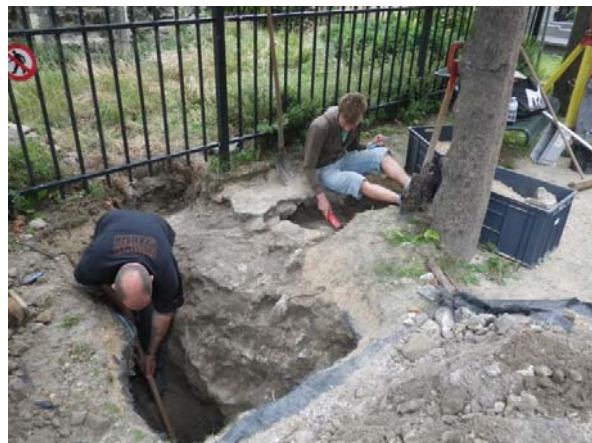
Figuur 4 : Foto, het vrijleggen van de fundering.
