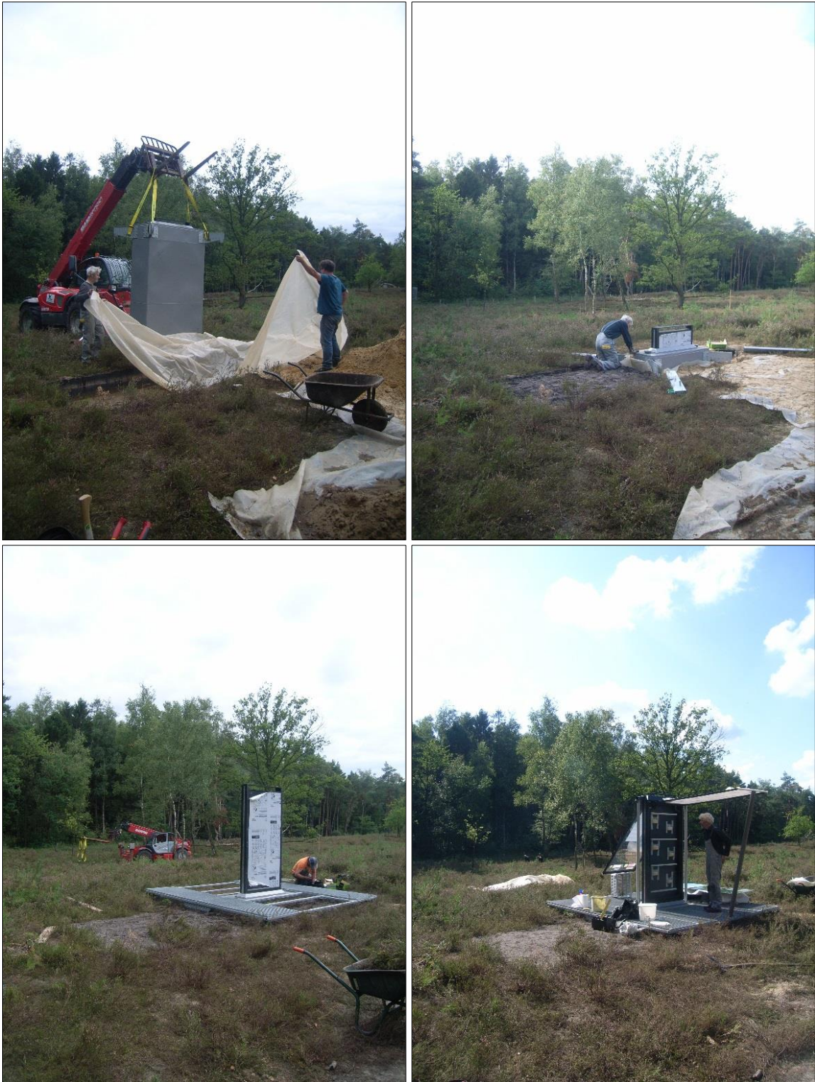
Fig. 11. Enkele beelden van de installatie van de bodemschuif.
