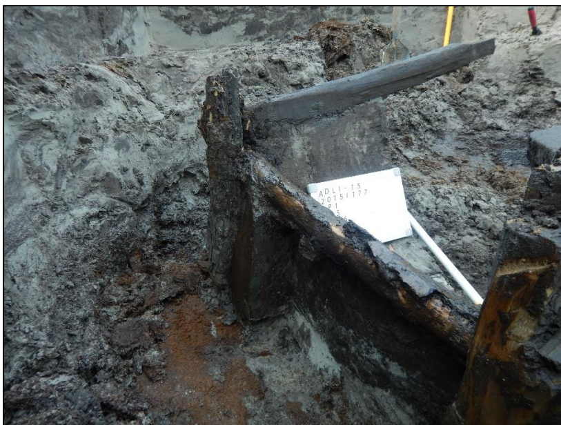
Fig. 2: de bekisting van de waterput.
