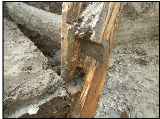
Figuur 40: Detailopname van de bevestiging van de dwarsbalken aan de hoekbalken van S576.
