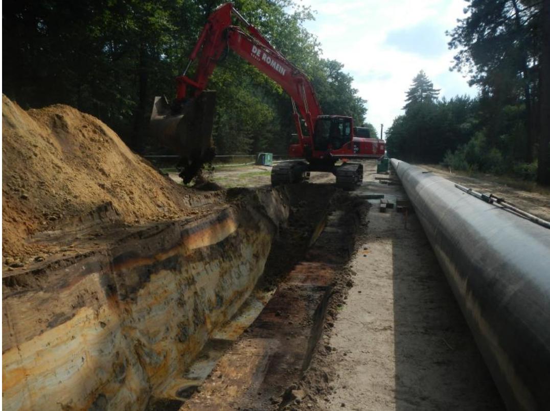
Afbeelding 5: De uitgegraven sleuf in AB3.
