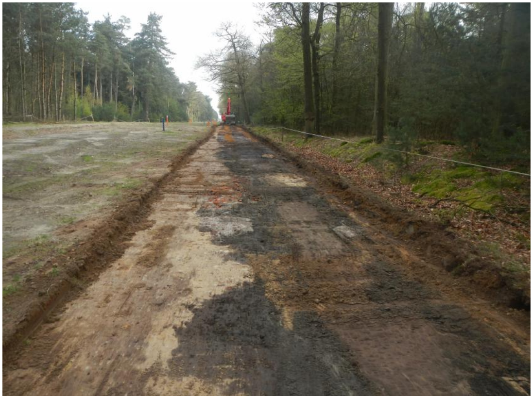
Afbeelding 9: Het afgraven van de grindbaan bij AB3.
