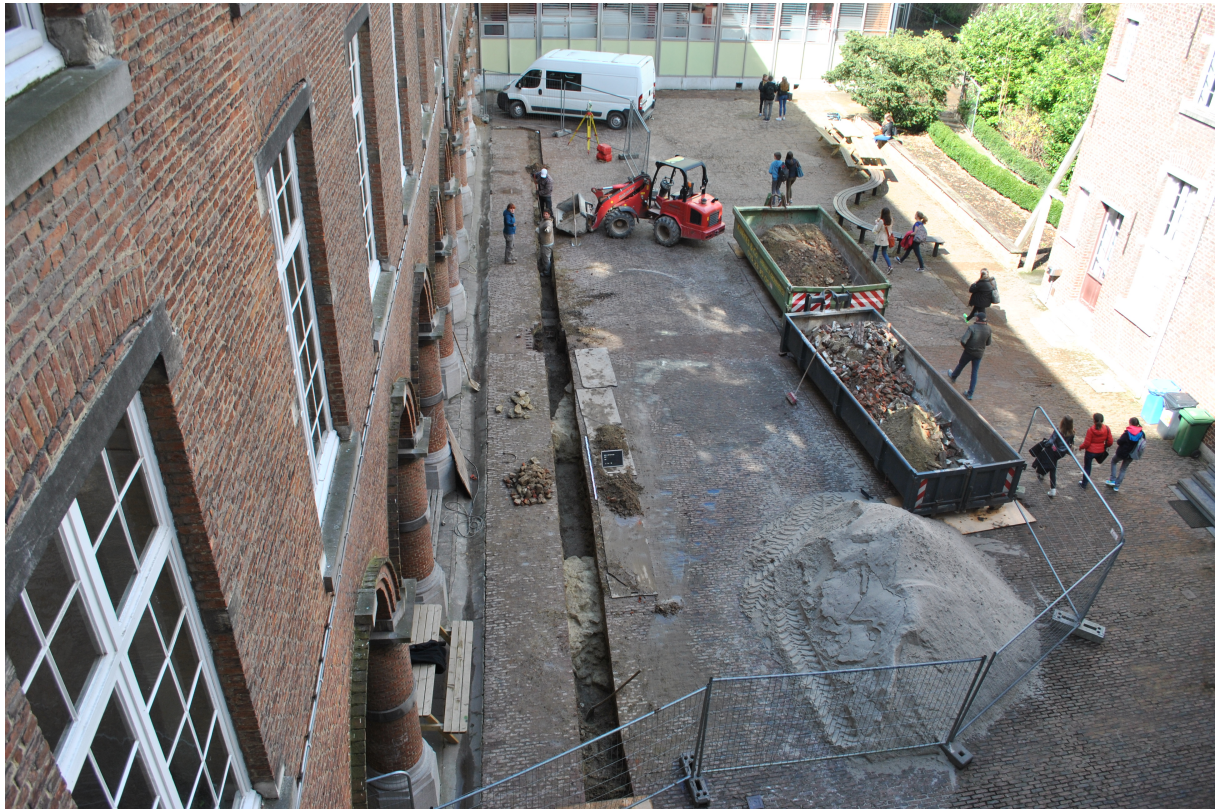
Fig. 2.1: Zicht op de graafwerken op de speelplaats.
