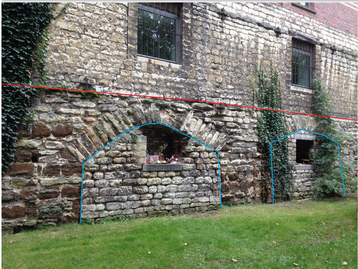
Fig. 3.9: Zicht op de opbouw van de stadsmuur (ter hoogte van het Handbogenhof). Doordat de aarden wal die tegen de fundering lag, verdwenen is, zijn de spaarbogen op poeren zichtbaar. Later zijn de openingen onder de spaarbogen opgevuld. De rode lijn geeft aan tot waar de aarden wal de fundering bedekte.
