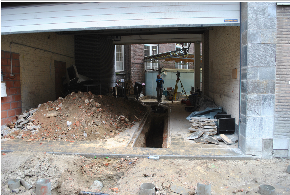
Fig. 2.2: Zicht op de sleuf binnen het gebouw aan de straatkant.
