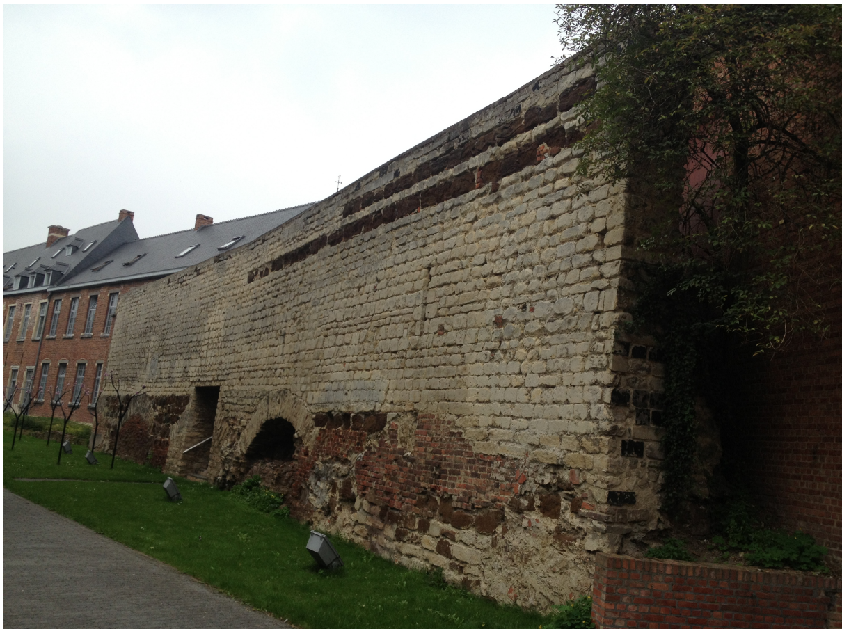
Fig. 1.9: Zicht op een bewaard stuk van de eerste stadsmuur (veldzijde), met op de achtergrond het Iers College.
