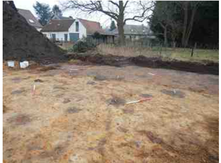
DSCN8417.JPG - Spoornummer(s): / - Inventarisnummer(s): / - Structuur: Hoofdgebouw 6 - Zone/Werkput/Kijkvenster/Vlak: /
