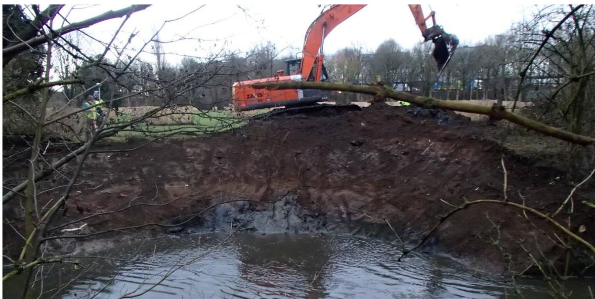
Figuur 26: foto van de afgraving van de oever op onderzoekslocatie 1. De foto is genomen richting het zuiden, de E34 is in de achtergrond zichtbaar
