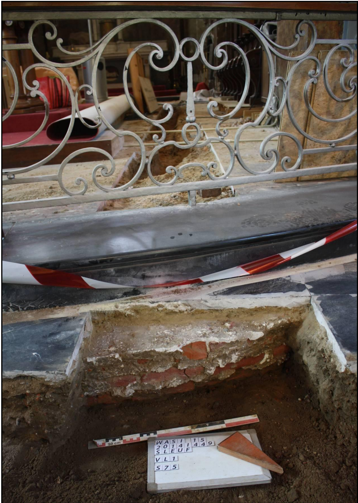
Figuur 46: Fundering van de trap naar het koor.
