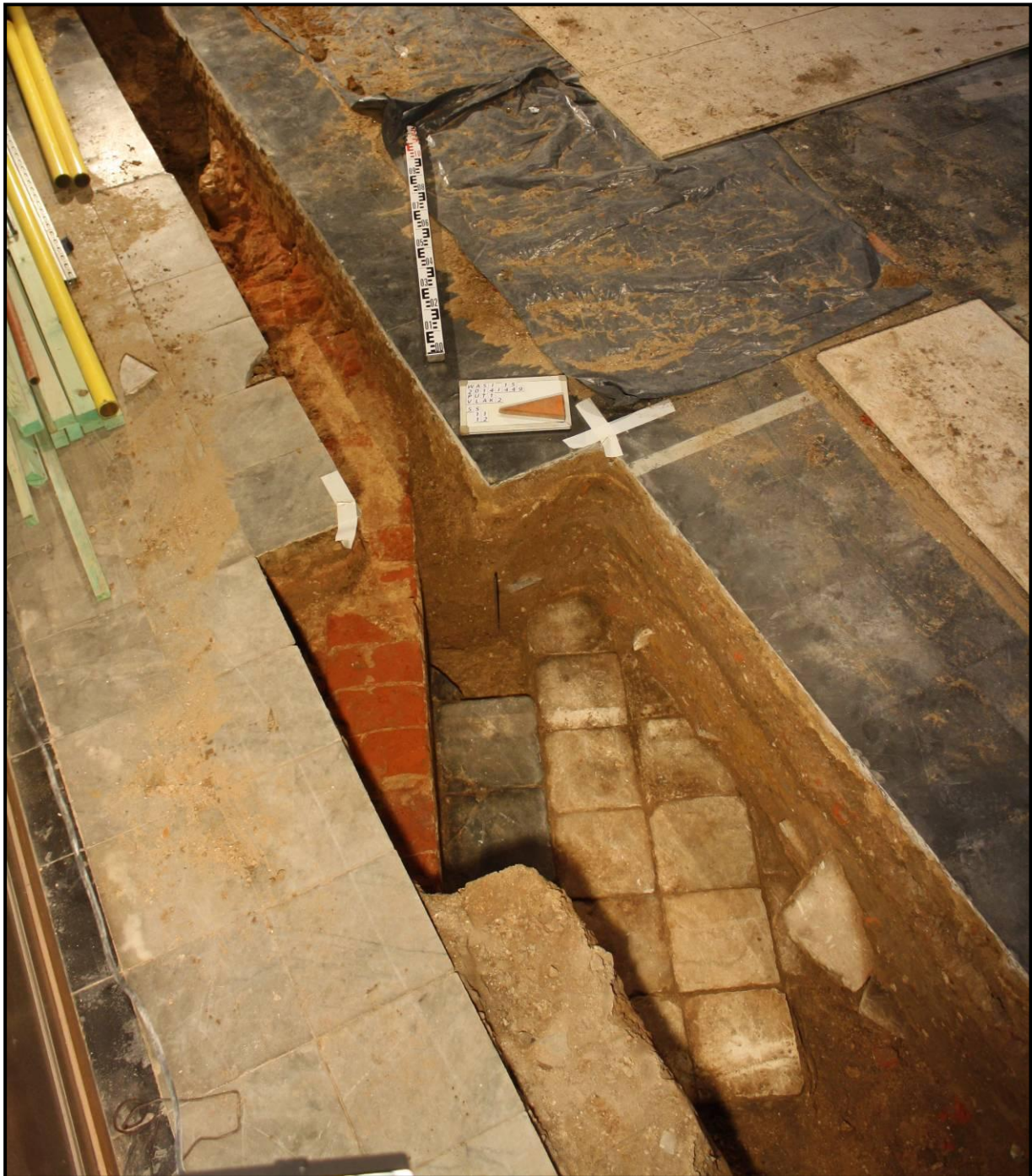
Figuur 14: Bovenaanzicht op de oude muur in baksteen met buitenste natuurstenen parament, met een bijna oostwest oriëntatie.
