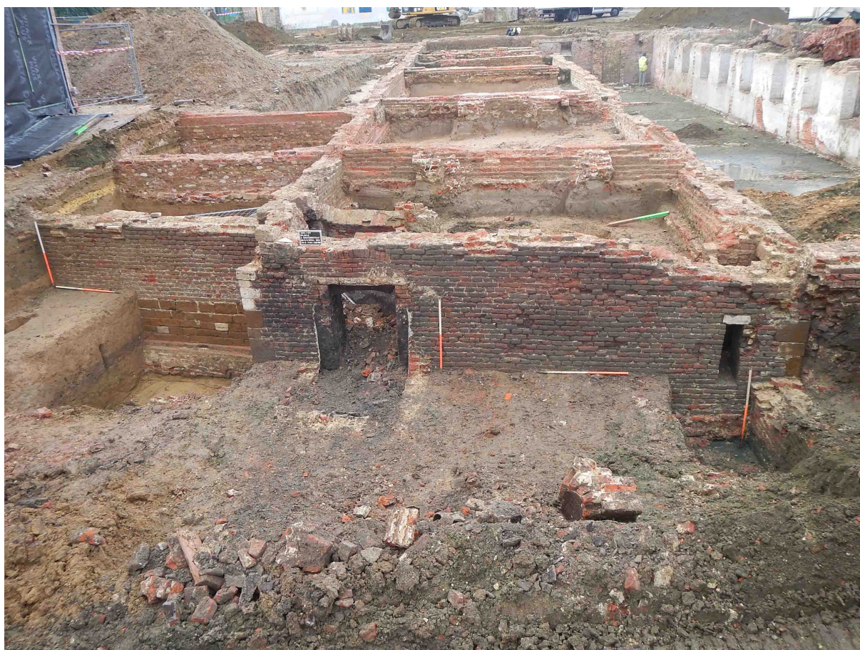
Fig. 23: Zicht op de noordoostelijke gevels van de eerste kasteelfase (M146 - links met parement) en de tweede kasteelfase (M66 - rechts met aan beide zijden natuurstenen hoekstenen)
