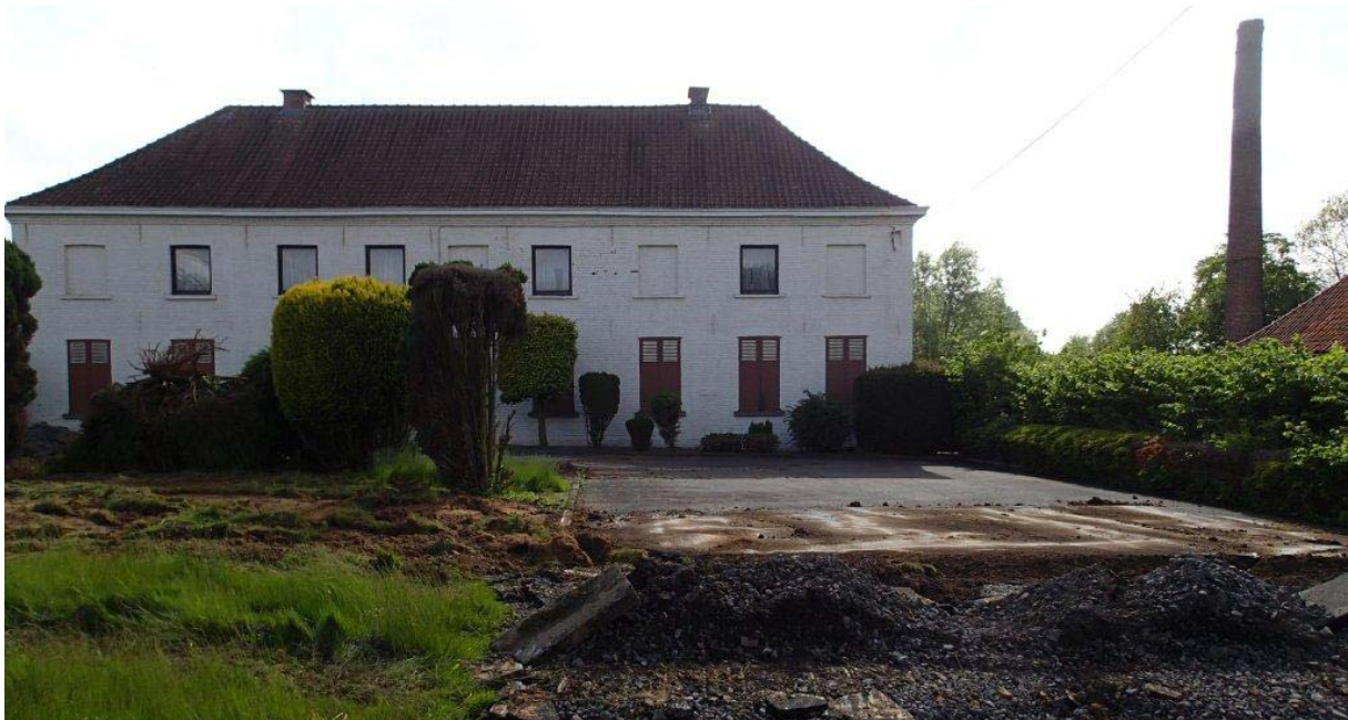
Figuur 4. Beeld van het onderzoeksgebied op 22 augustus 2014, foto in richting Westen (foto: Van Looy Bouwgroep).
