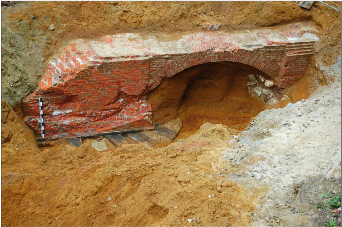
FIG. 26: Zicht op de volledige werkput met de funderingsresten.
