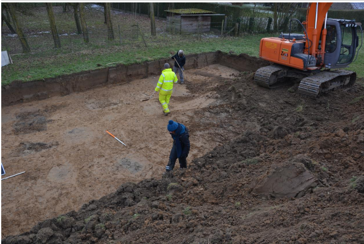
Fig. 2.1: Aanleg van werkput 2.
