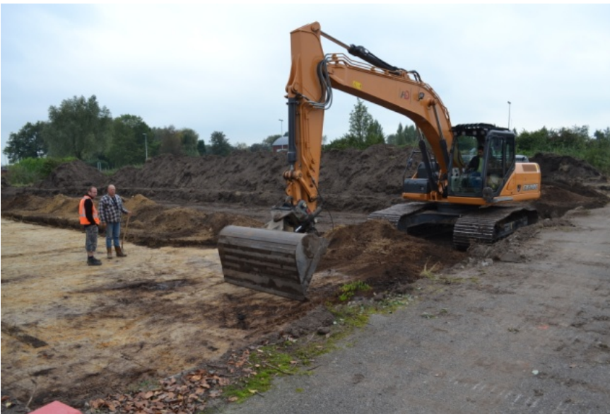
Afb. 5. Machinaal aanleggen van het vlak in zone 1.
