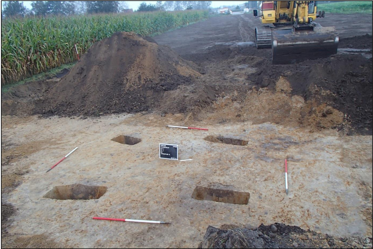
Figuur 60 Vierpalige spieker, structuur 8 in werkput 7.
