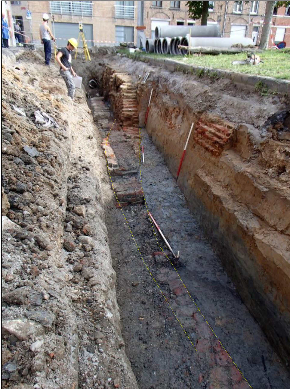
Figuur 56: Overzicht op de sleuf, met duidelijke curve van S4.4.001. De linkerzijde van de muur is, vooraan in beeld, weggegraven bij voorgaande rioleringswerken.
