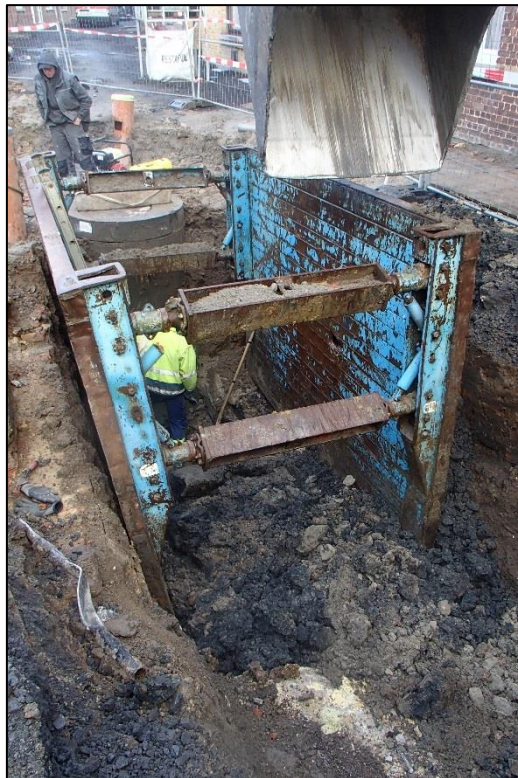
Figuur 73: Voorbeeld van de beperkte zichtbaarheid door het gebruik van sleufbeschoeiing.
