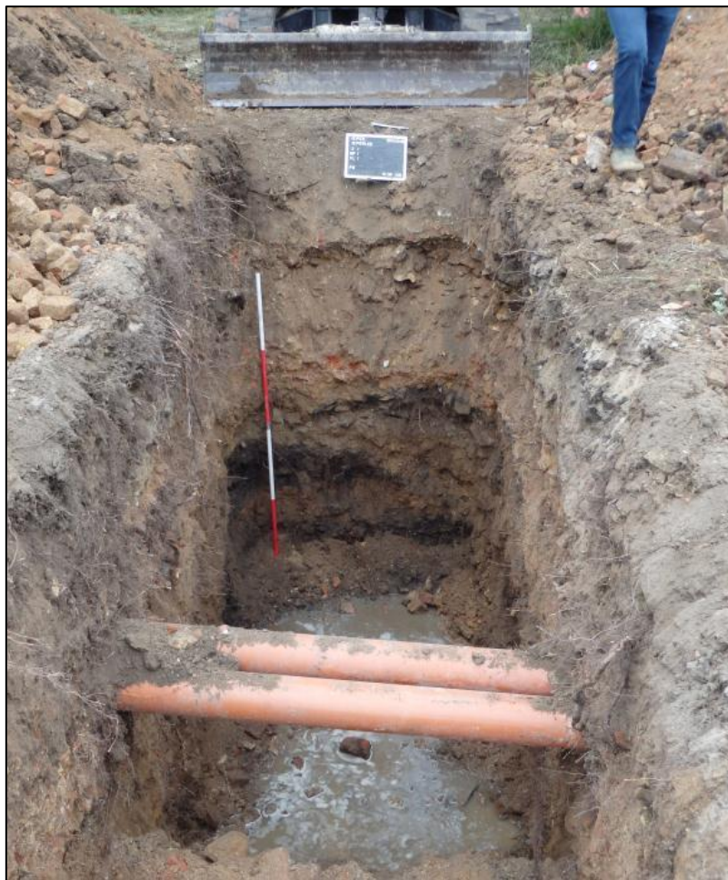
Figuur 20: Dempingspakketten en leidingen werkput 1.1.
