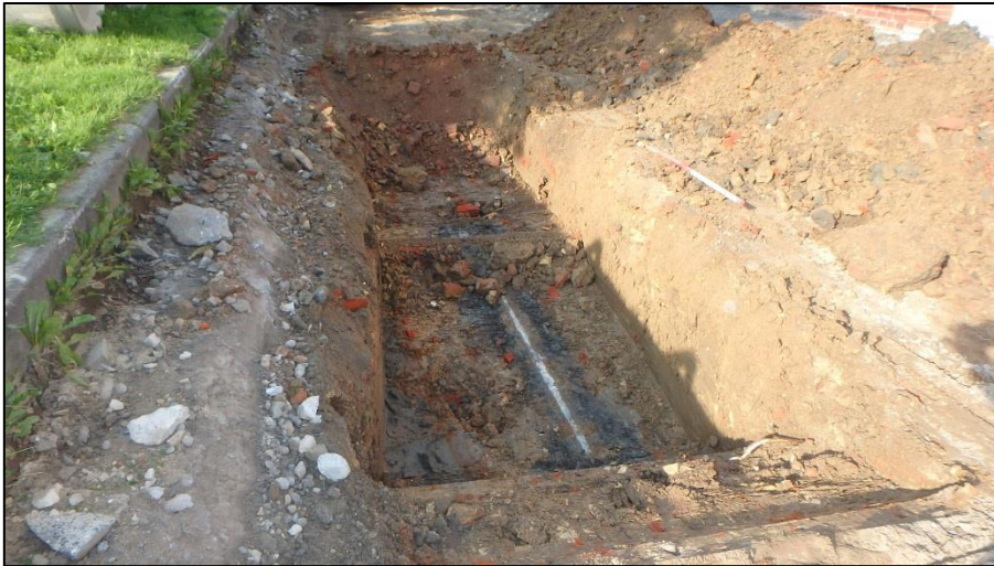
Figuur 53: Riolering zichtbaar in één van de werkputten.
