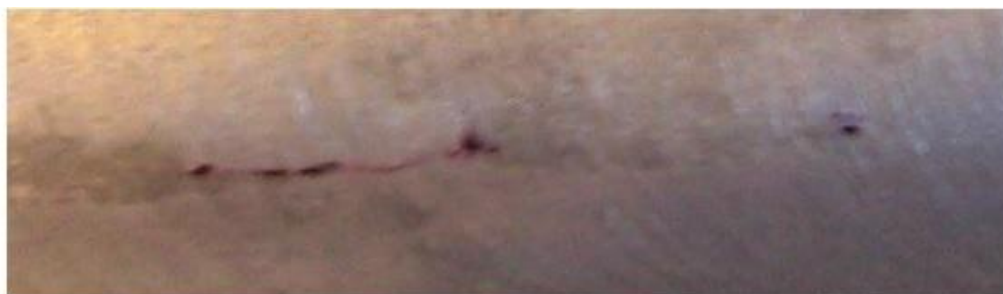
Рисунок 3 - Фрагмент внутренней трещины в центральных слоях сварного шва после вышлифовки и контроля проникающими веществами
