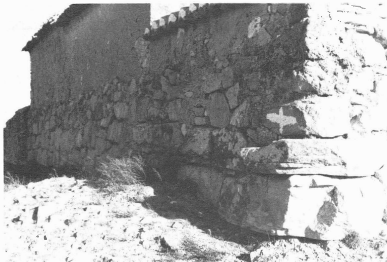
Fig. 4. Muro de sillares de la fachada norte.
