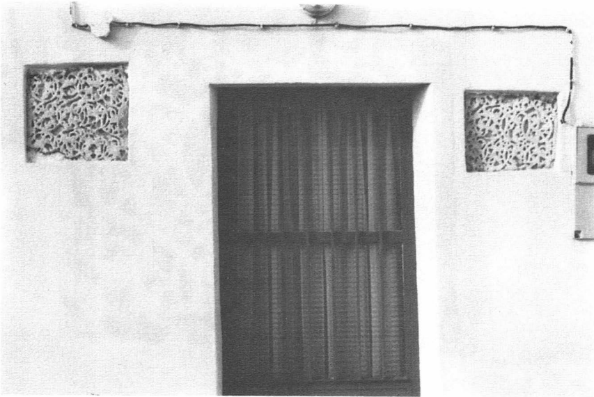
Fig. 6. Puerta del cortijo con las dos placas en relieve.
