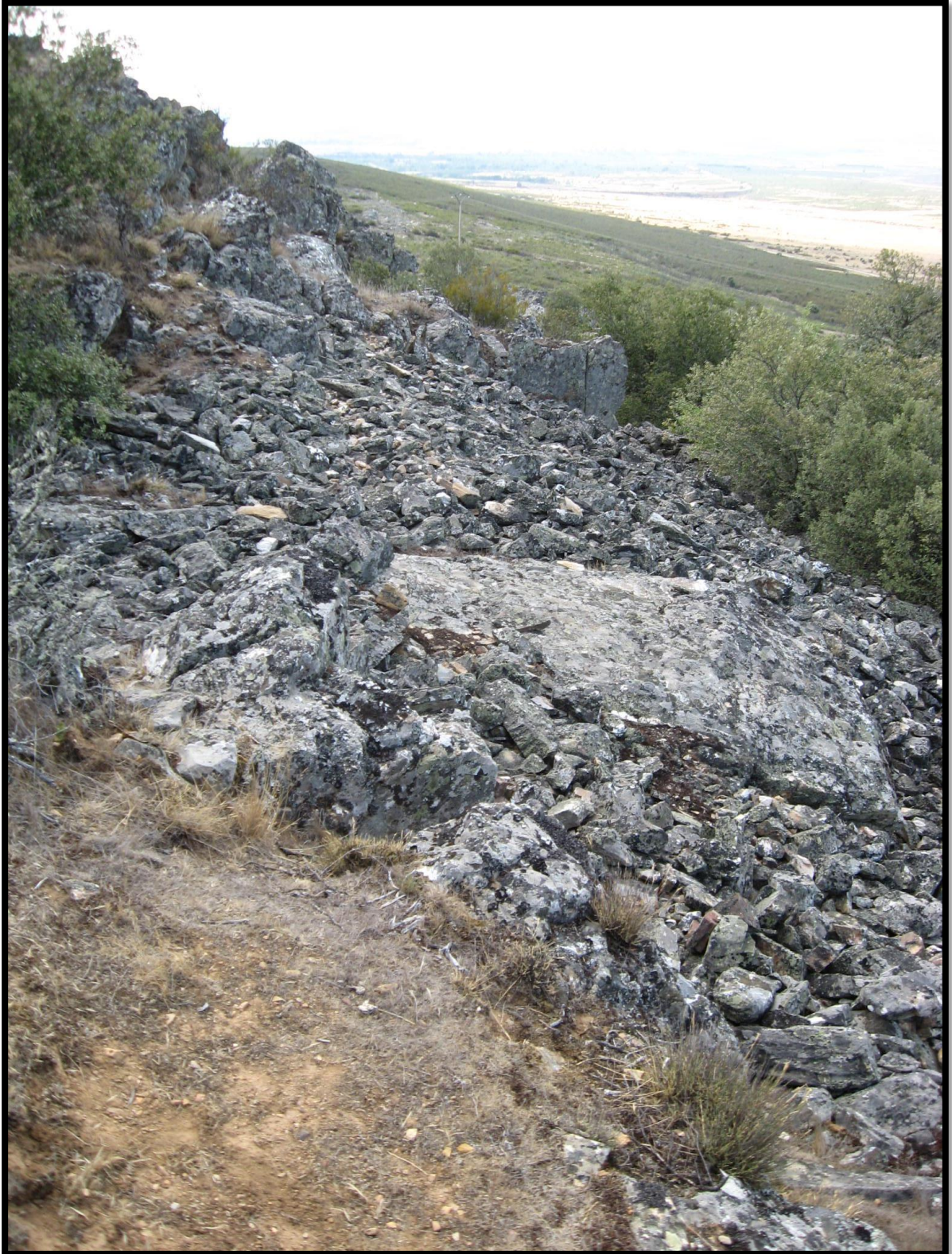
Fig. 12.- Derrumbe de la muralla de El Castro (Abejera) (Fotografía: ZamoraProtohistórica).
