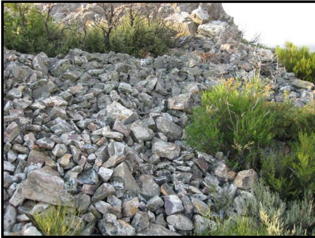
Fig. 13.- Derrumbe de la muralla Sur del Corral de los Moros (Litos) (Fotografía: ZamoraProtohistórica.
