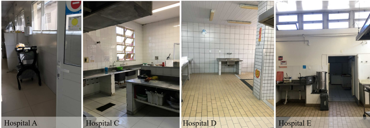
Figura 45 - Comparação dos revestimentos empregados nas cozinhas. Fonte: A autora.
