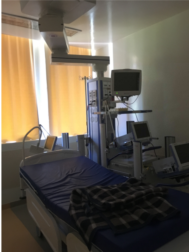
Figura 54 - Estativa da UTI geral do hospital E. Fonte: A autora.
