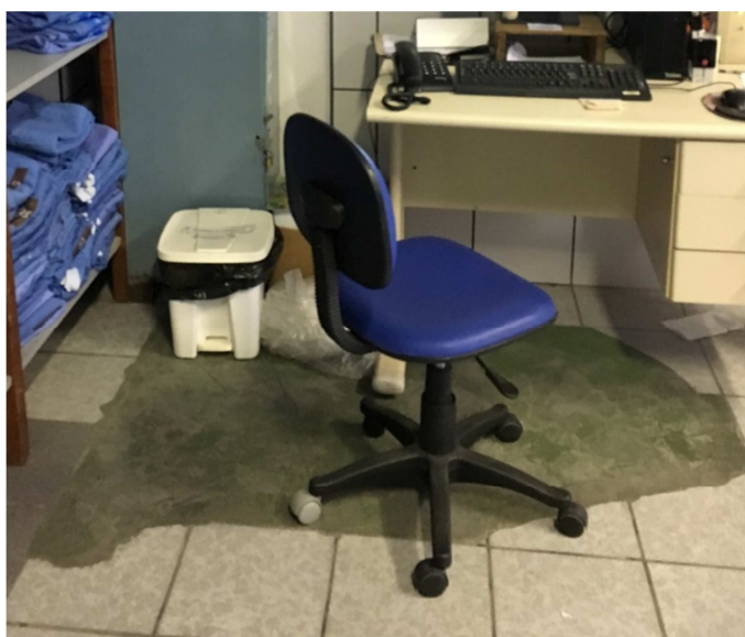
Figura 52 - Contrapiso exposto devido à ausência de placas cerâmicas no hospital D. Fonte: A autora.
