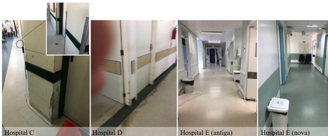
Figura 32 - Comparação dos revestimentos empregados nos corredores da emergência. Fonte: A autora.
