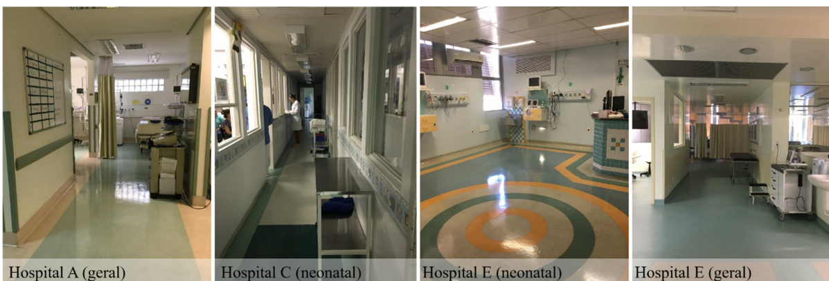
Figura 42 - Comparação dos revestimentos empregados nas unidades de terapia intensiva. Fonte: A autora.
