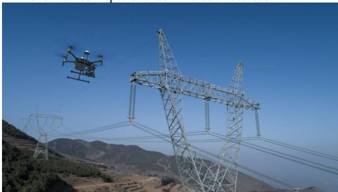
Figura 1- Drone Matrice inspecionando linha de alta tensão
