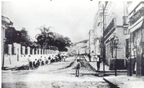
Figura 79 – Lado direito da Praça XV de Novembro e a instalação da rede de água em 1909
