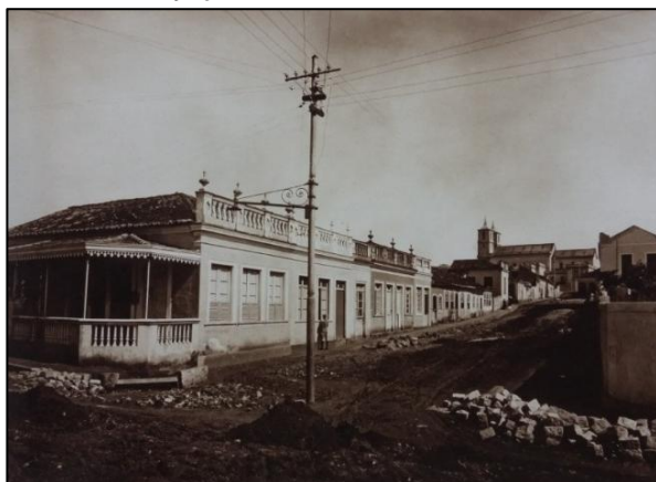
Figura 45 – Instalação da luz elétrica e calçamento em 1910
