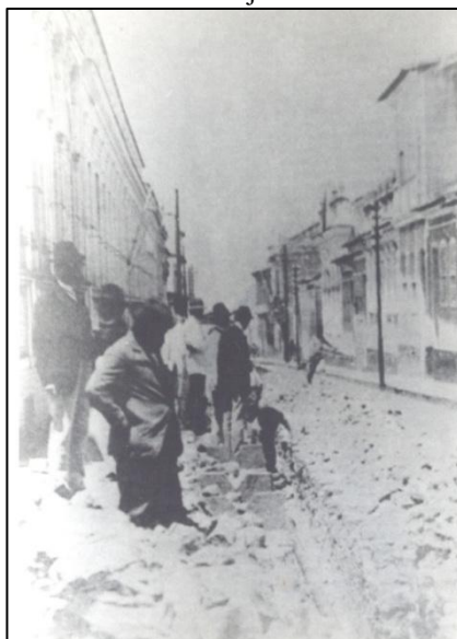
Figura 36 – Obras da rede de abastecimento de água na Rua Trajano em 1919
