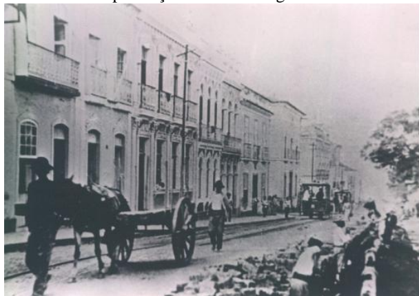
Figura 80 – Lado leste da Praça XV de Novembro e a implantação da rede de água em 1908
