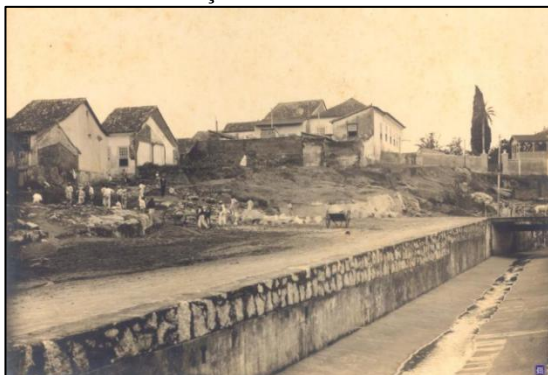
Figura 41 – Canalização do rio da Fonte Grande e demolição do bairro Pedreira em 1919
