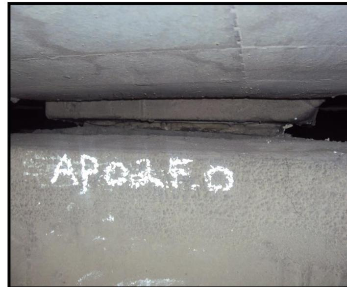
**PREVER NO PROJETO DISPOSIÇÕES QUE PERMITAM FÁCIL E RÁPIDA REPARAÇÃO OU SUBSTITUIÇÃO DOS APARELHOS DE APOIO, JUNTAS DE DILATAÇÃO, GUARDA CORPOS.**
