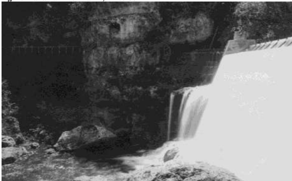
Fig. 58 Tanamá River Dam, Arecibo
