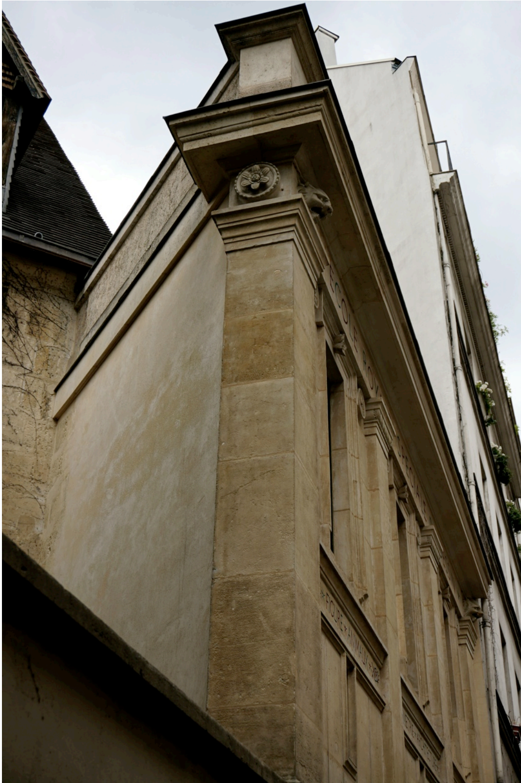
2.3.26 S.-C. Constant-Dufaux, l'École de Dessin, façade on the rue Racine; photograph by Ralph Ghoche.
