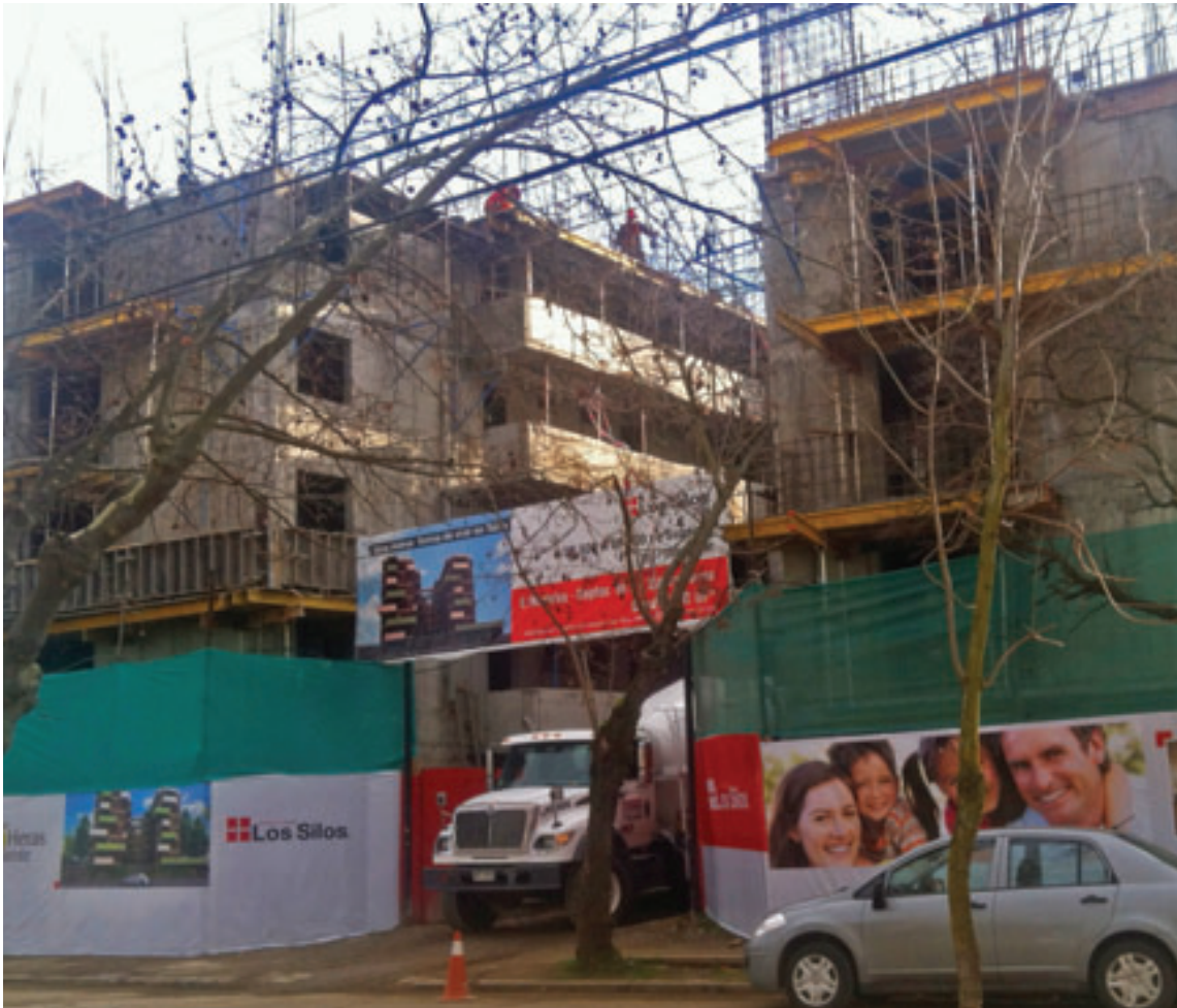
New Housing Construction in Talca / Construcción de Nuevas Viviendas en Talca.
