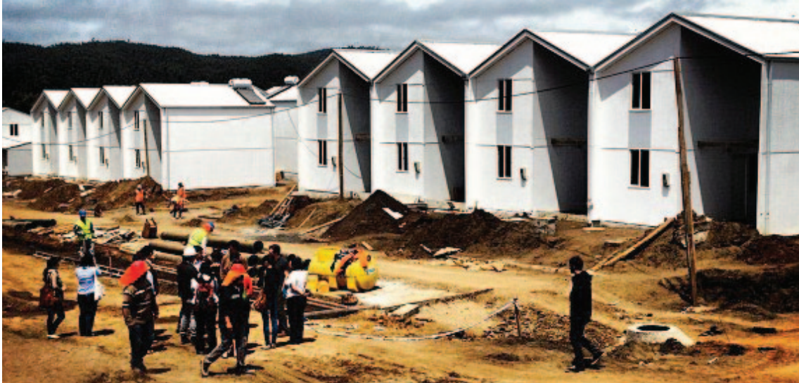
New Housing Construction in Talca / Construcción de Nuevas Viviendas en Talca.
