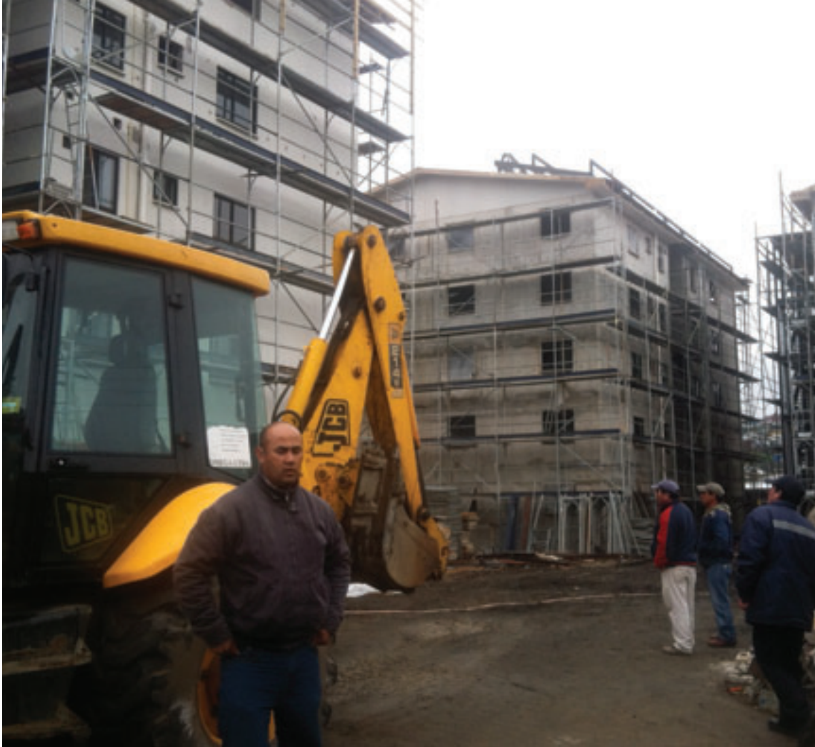
New Housing Construction in Talca / Construcción de Nuevas Viviendas en Talca.
