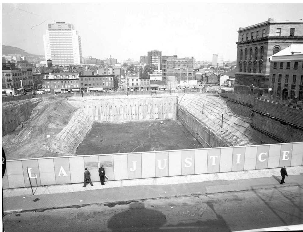
Figure 14. Construction site of the new Courthouse (Palais de Justice) Archives de la Ville de Montréal VM94-A322-2
