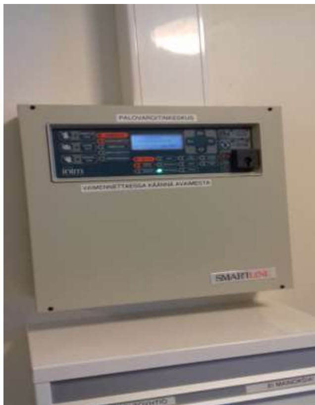
Kuva 3. Esimerkkikohteen palvaroitinjärjestelmän keskusyksikkö.
