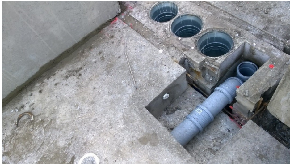
Kuva 18. Edellisen kerroksen tekniikkaseinän yläpää ja tekniikkalaatan viemärin varuskolo.
