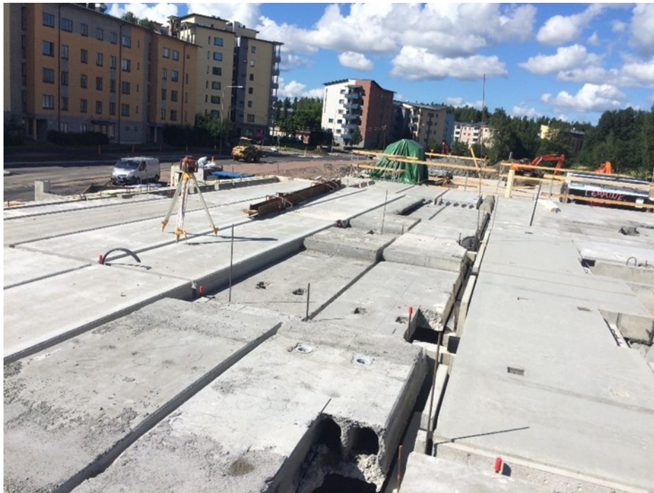
Kuva 14. Ontelolaattakenttä asennettuna ennen saumavaluja.
