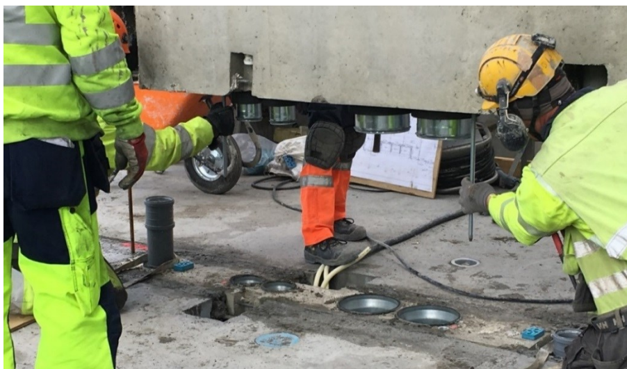
Kuva 19. Tekniikkaseinäasennus.
