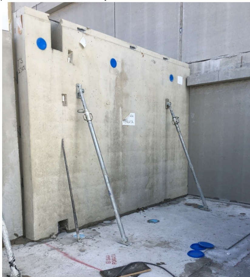
Kuva 20. Tekniikkaseinä on asennettu ja vinotuettu.
