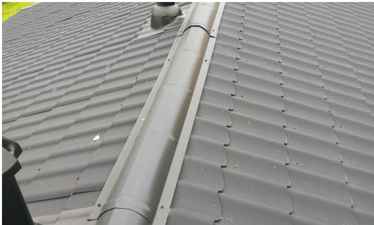
Kuva 8. Osa kateruuveista on ruostunut.
