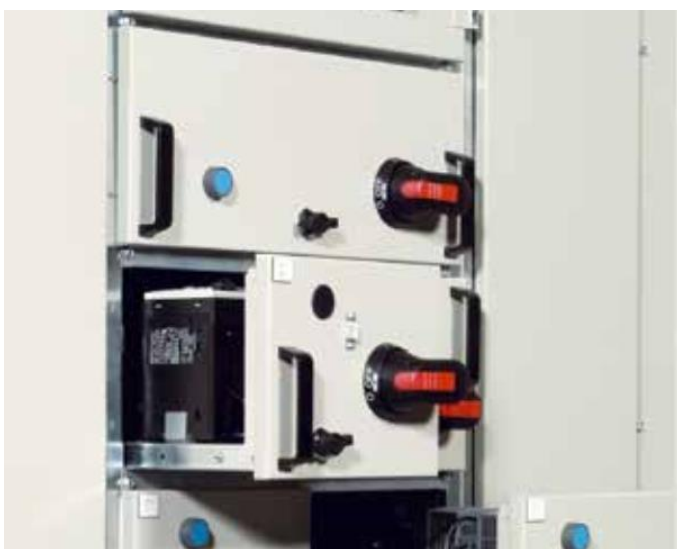
KUVA 6. Ulosvedettävä lähtöyksikkö (UTU 2018a)
