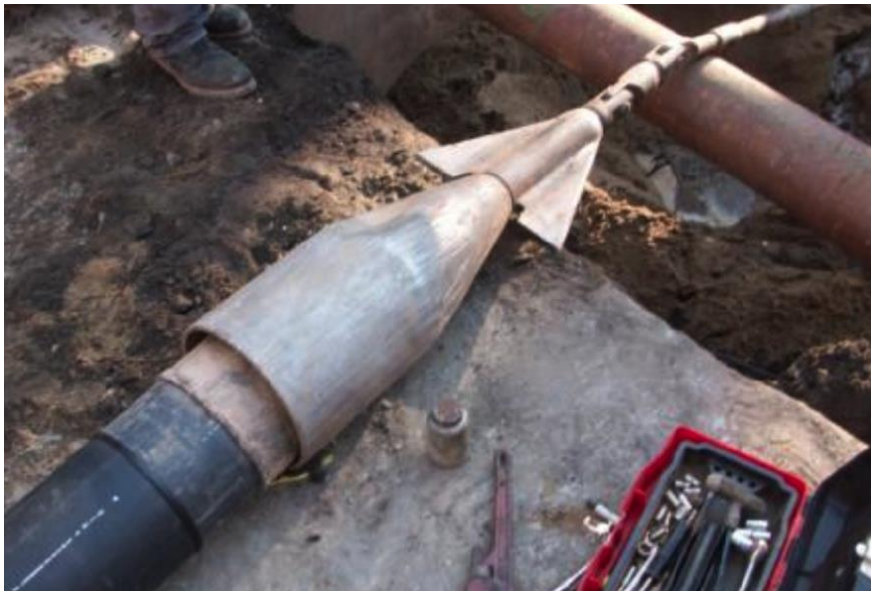
Kuva 7. Leikkuuterä ja avennin [17]
