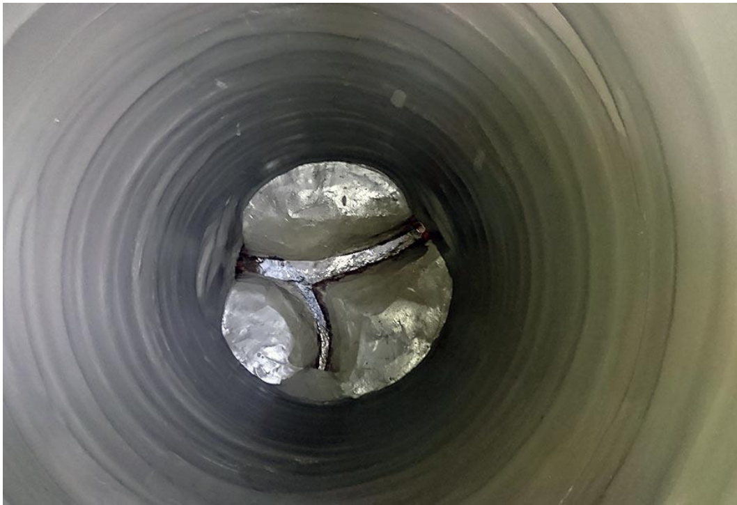
Kuva 29. Valmis ruiskubetonoitu kaivo [12]
