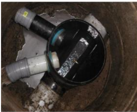
Kuva 31. Asennettu korjauskaivo ja havainnekuva kaivosta [6]
