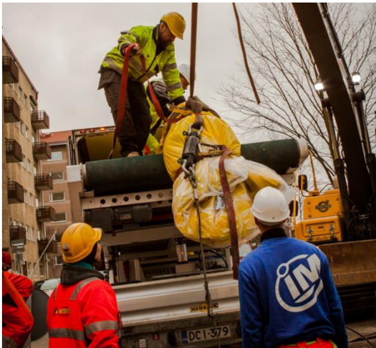
Kuva 17. Vetovaijeri kiinnitettynä sukan päähän valmiina vedettäväksi linjaan [29]
