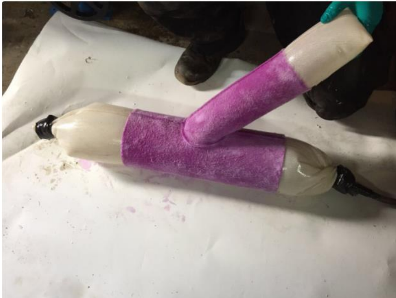
Kuva 22. Haarayhde asennettuna pakkaajan päälle [19]
