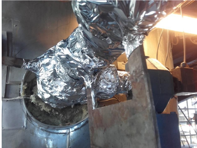
Kuva 2. Kannakkeiden kohdat on varmistettu huolellisesti.
