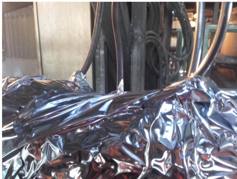
Kuva 3. Kaapelien kohdat on varmistettu huolellisesti.
