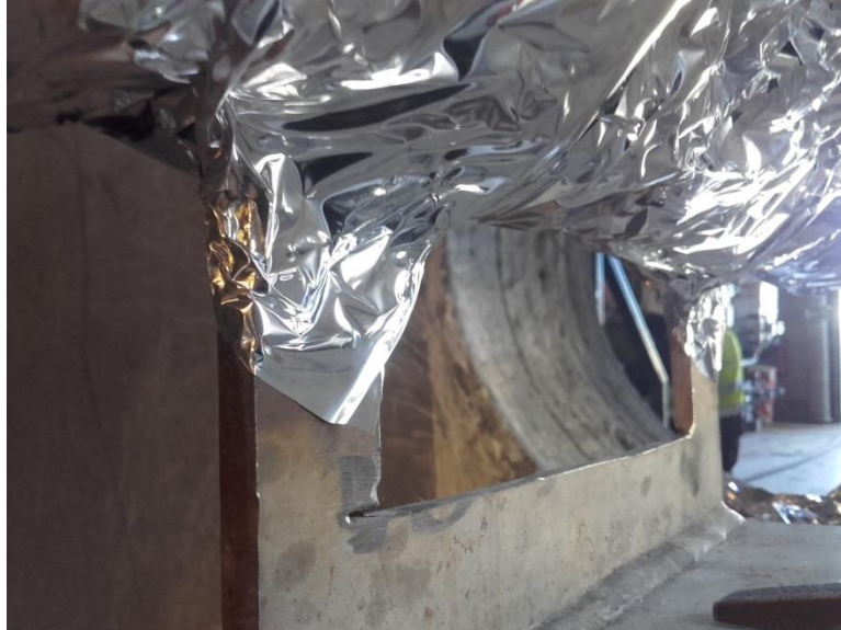
Kuva 4. Laippojen kohtiin lisätään ylimääräinen kerros alumiinifoliota.
