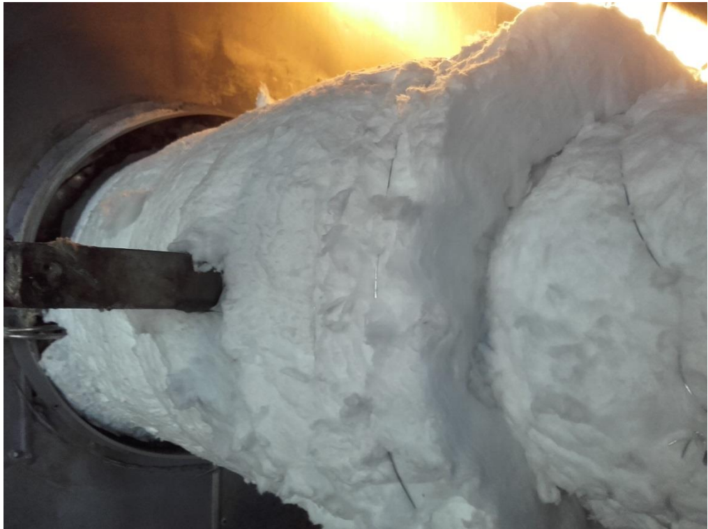
Kuva 6. Oikein asennettu keraamivillakerros.
