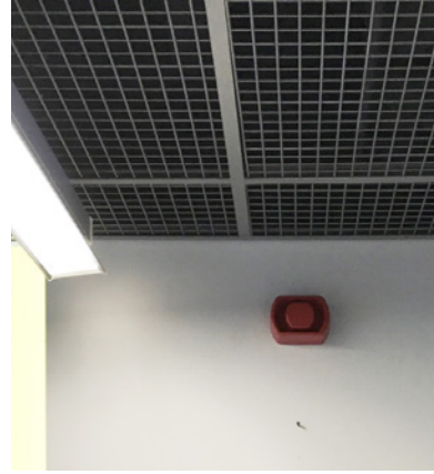
Kuva 5. Vilkkuvalla valolla varustettu palohälytintin toiminta- ja palvelukeskus Iiriksessä.
