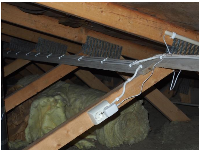
Kuva 24. Kameran pistorasia asennettuna kattotuoliin.
