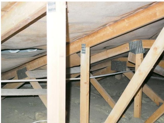
Kuva 27. Ulkoseinän pistorasian kaapeloinnin putkitus välikatolla.
