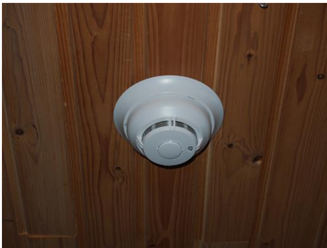
Kuva 12. Langaton, optinen fotoelektroninen savuilmaisin.
