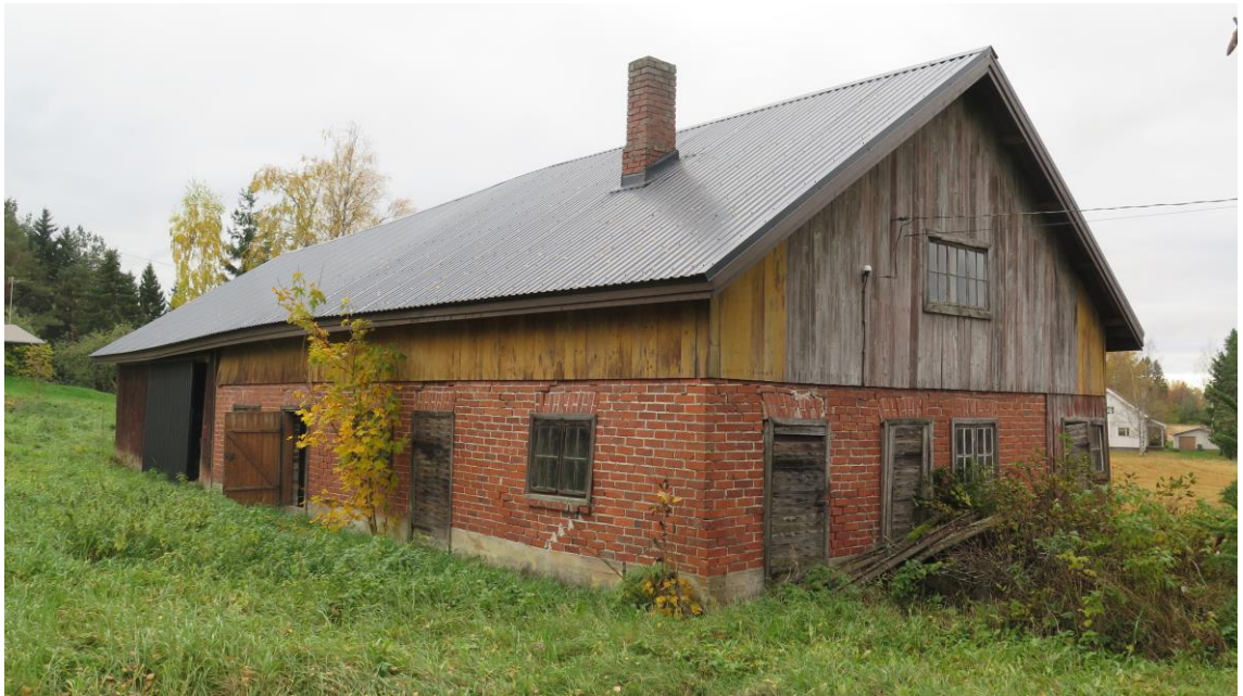
Kuva 14 Navetan nykytilanne pohjoiseen päin.
