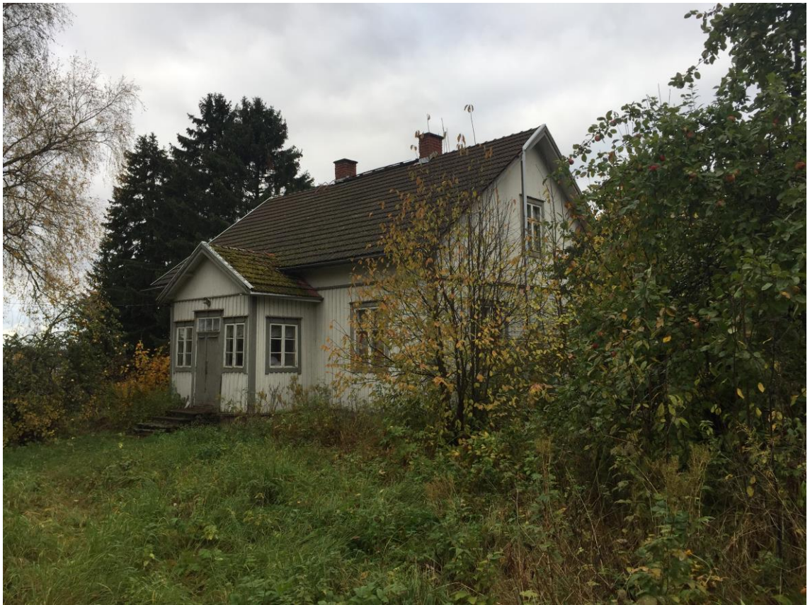
Kuva 9 Päärakennuksen nykytila aitan kohdalta katsottuna.
