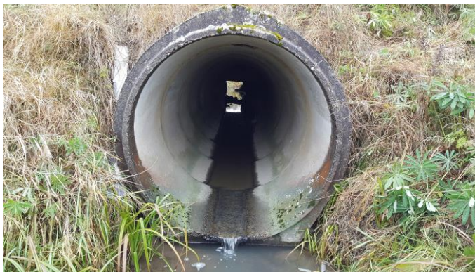
KUVA 3. Kivirumpu, jota jatkettu betoniputkirummulla (Sitowise 2016)
