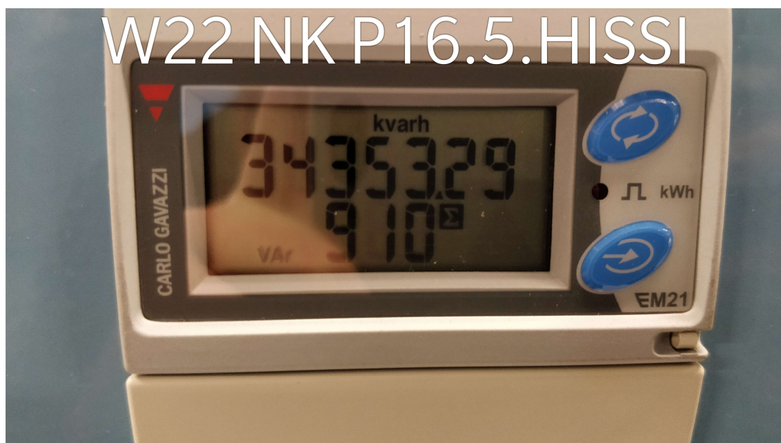
Kuva 11. Hissinousukeskuksen energiamittari.
