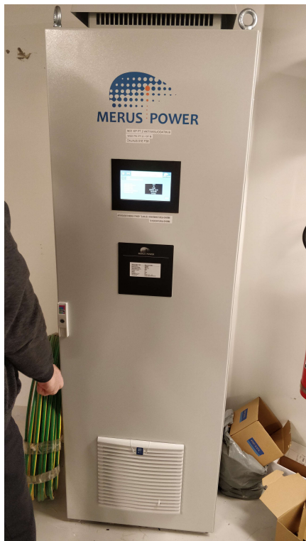
Kuva 6. Aktiivisuodatin B.
