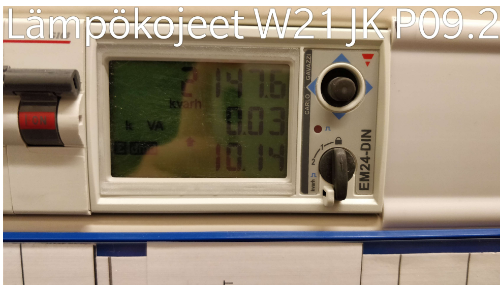
Kuva 15. Lämpökojeiden energiamittari.
