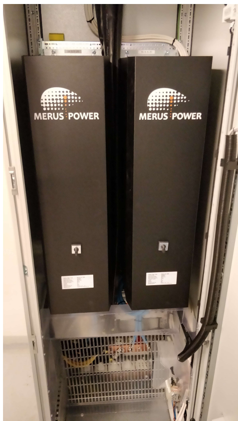
Kuva 7. Kaksi kappaletta 100 A:n suodatinta.
