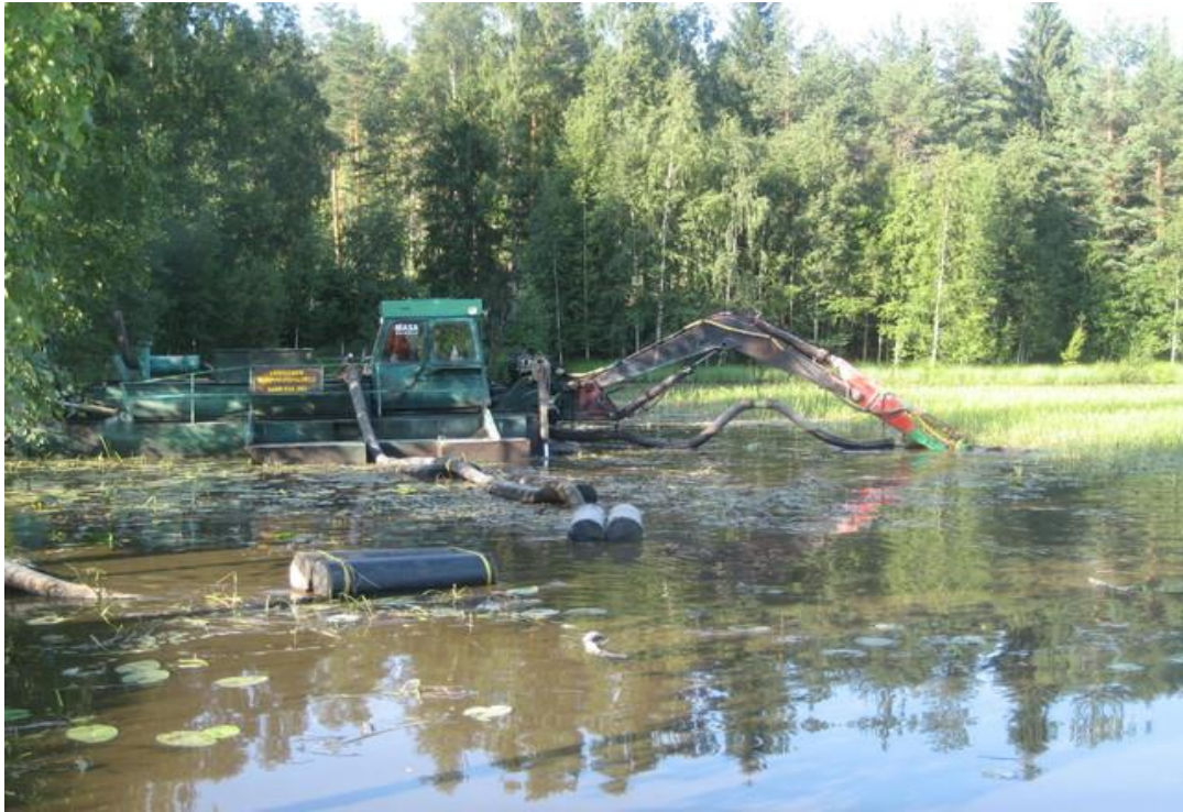
Kuva 4. Imuruoppausta rantavesistössä (Kuva: ruoppauspalvelu.com).
